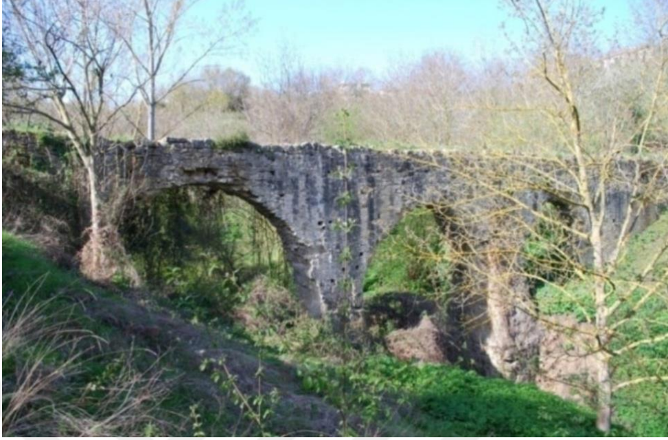
Res. 29 – Paşasuyu 18 No.lu Su Kemer
