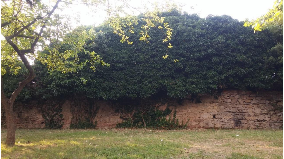
Res. 18 – Nikomedia Surları / Bayraktar Burcu Batısı (Dış Surlar)
