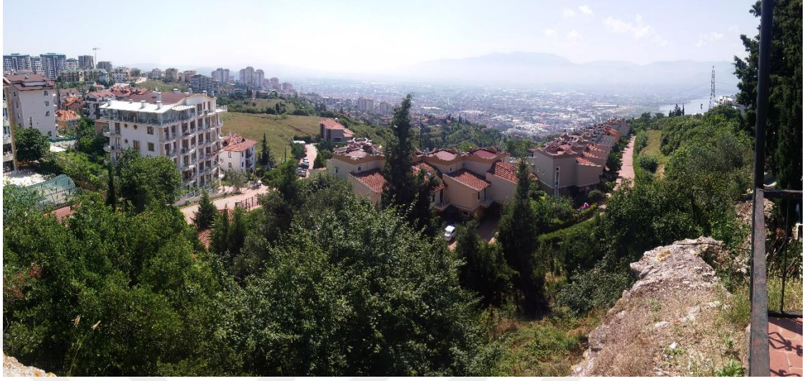
Res. 19 – Bayraktar Burcu’ndan Güneydoğuya Doğru Bakış (Dış Surlar)
