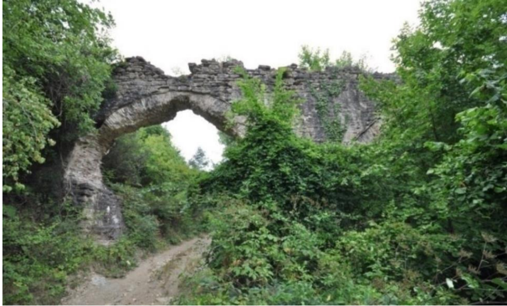
Res. 30 – Paşasuyu 11 No.lu Su Kemer
