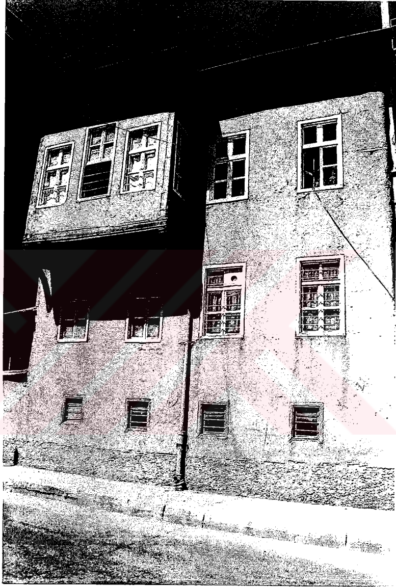
57- Abid Ağa Konağı çıkmalı güney cephesi
