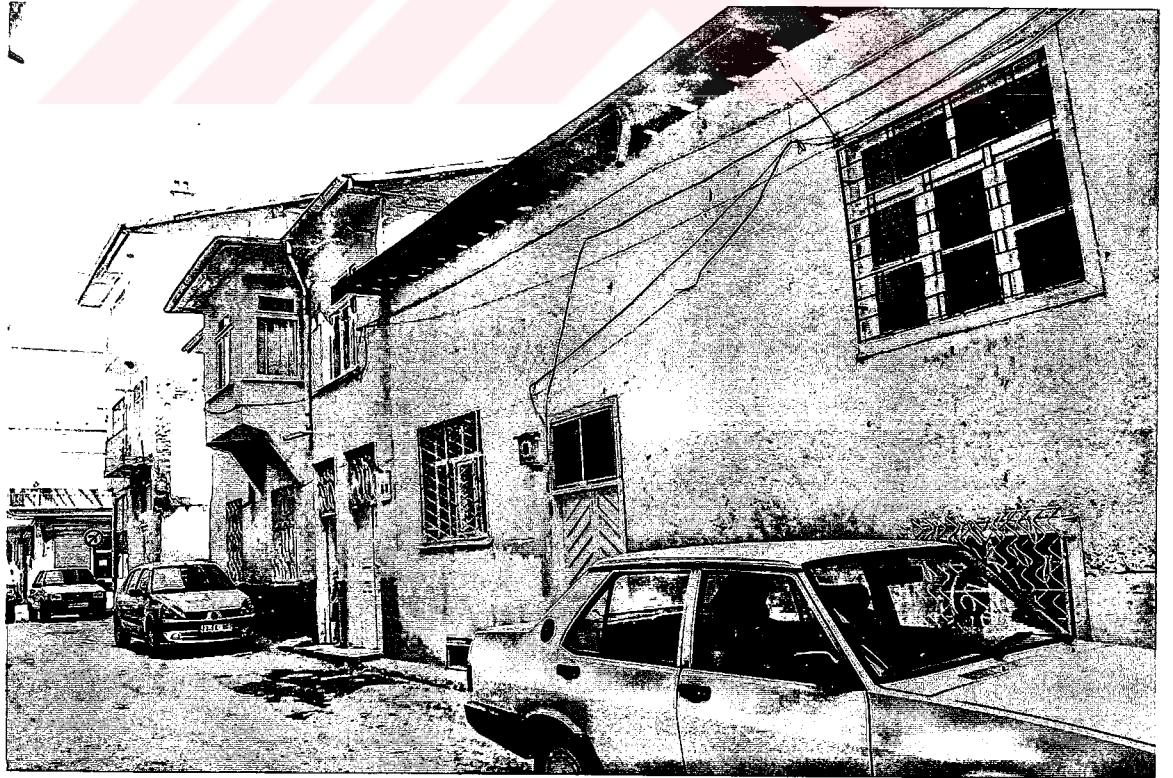
91- Mustafa Demirel Evi batı cephe güney uçtan görünüşü
