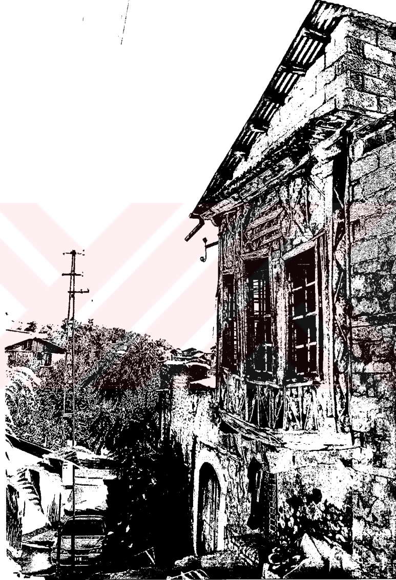
66- Nihat Bey Konağı, dođu yöndeki sokađa bakan odanın konsol ıkması ve ıkma yapım tekniđi.
