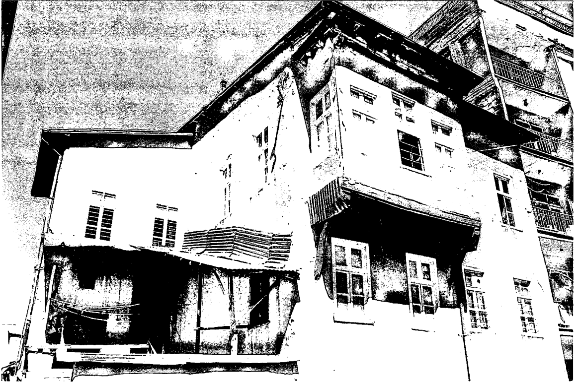
58- Abid Ağa Konağı çıkmalı güney cephe batı uçtan görünüşü
