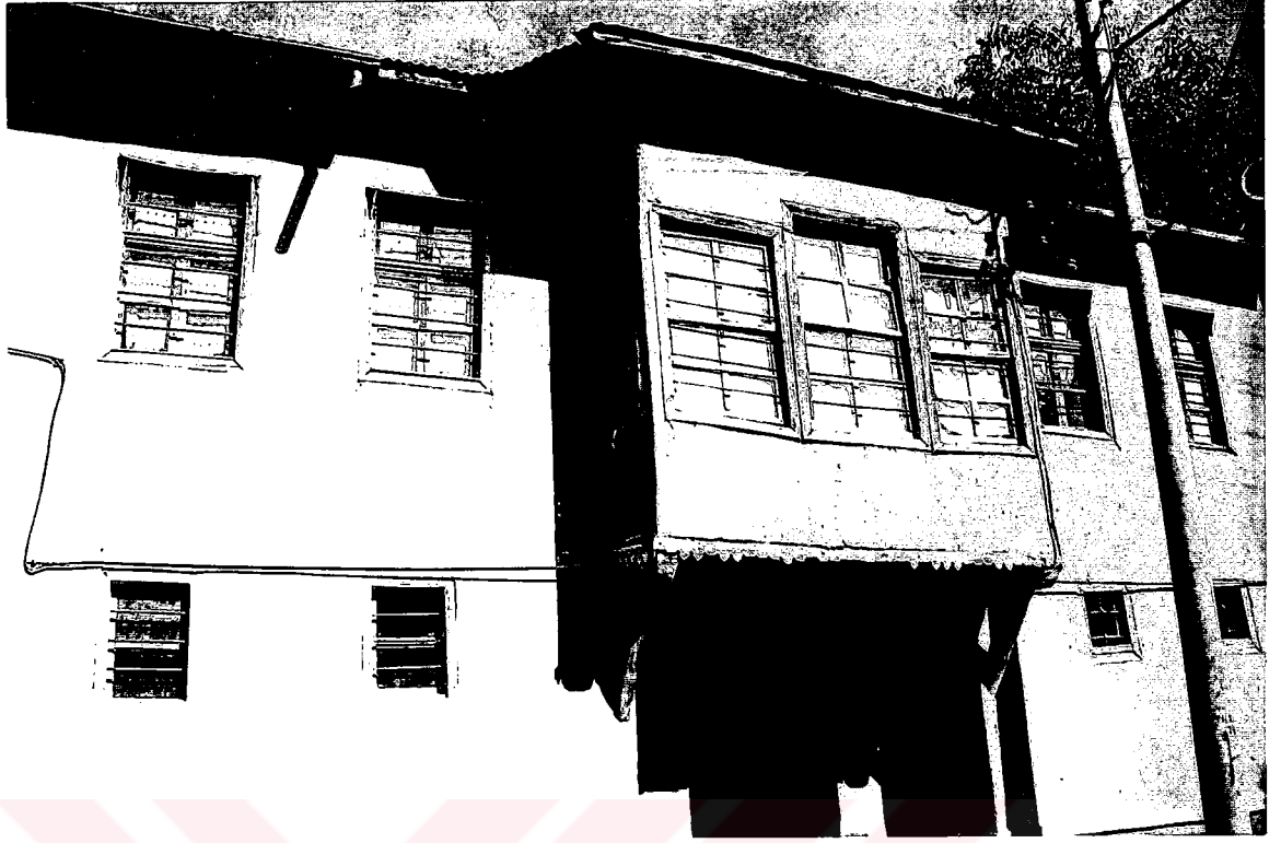
33- Naciye Hocanın Evi çıkmalı batı cephesi
