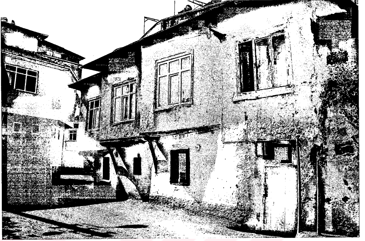
41- Celal Aksan Evi gönye çıkmalı sokak cephesi doğu uçtan görünüşü
