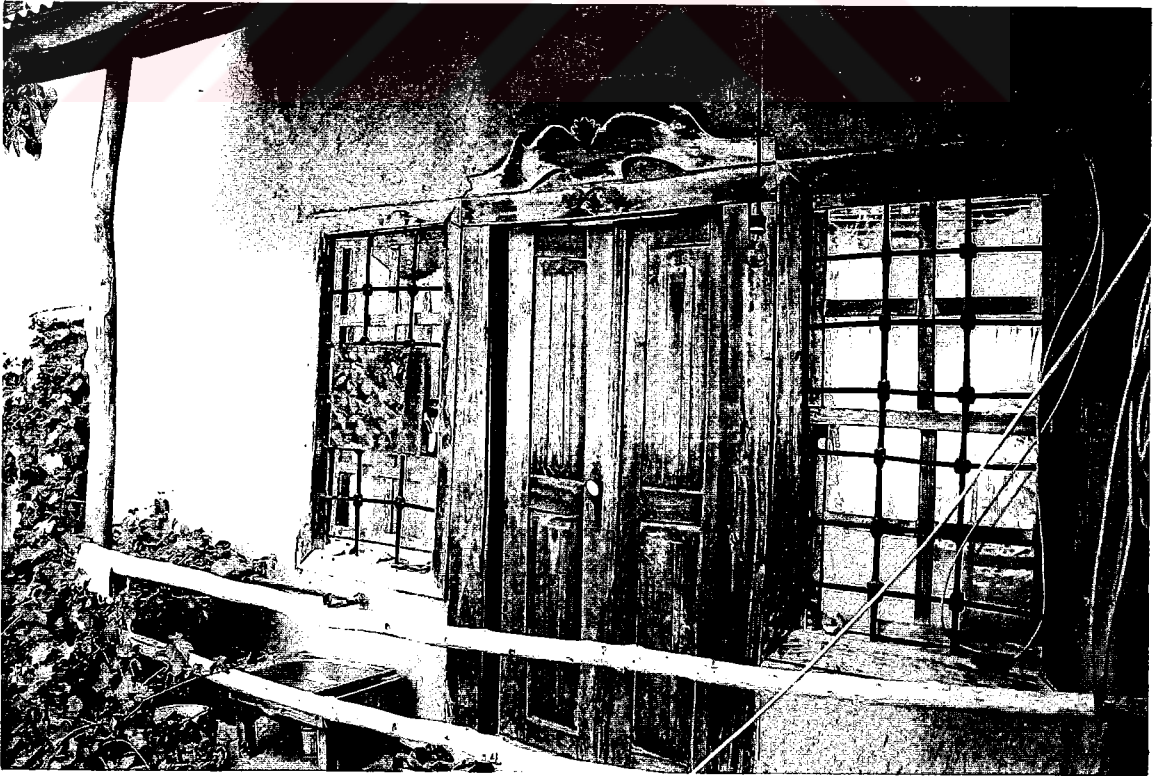
34- Naciye Hoca evinin üst kat çıkan balkonunun çift kanatlı ahşap cümle kapısı ve kapı üstündeki dilimli süsleme
