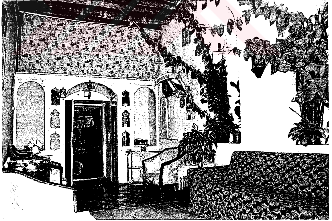
76- Oda girişinde içine alan, gönye çıkmalı odadaki musandıra ve sonradan kapatılan yuvarlak kemerli pencere içine yapılan taka
