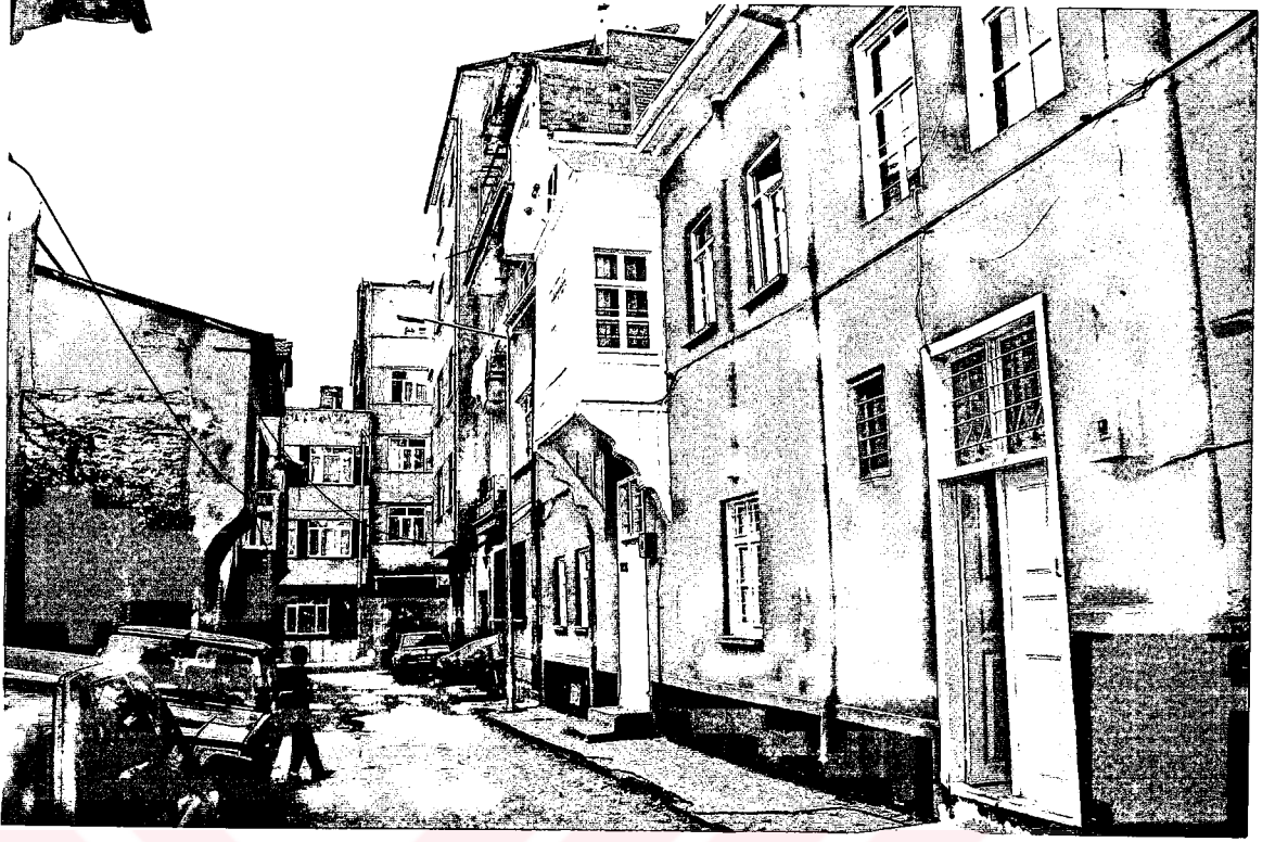
17- Kazım Efendi evinin dilimli elibögründelerde desteklenen çıkmasıyla sokak cephesi
