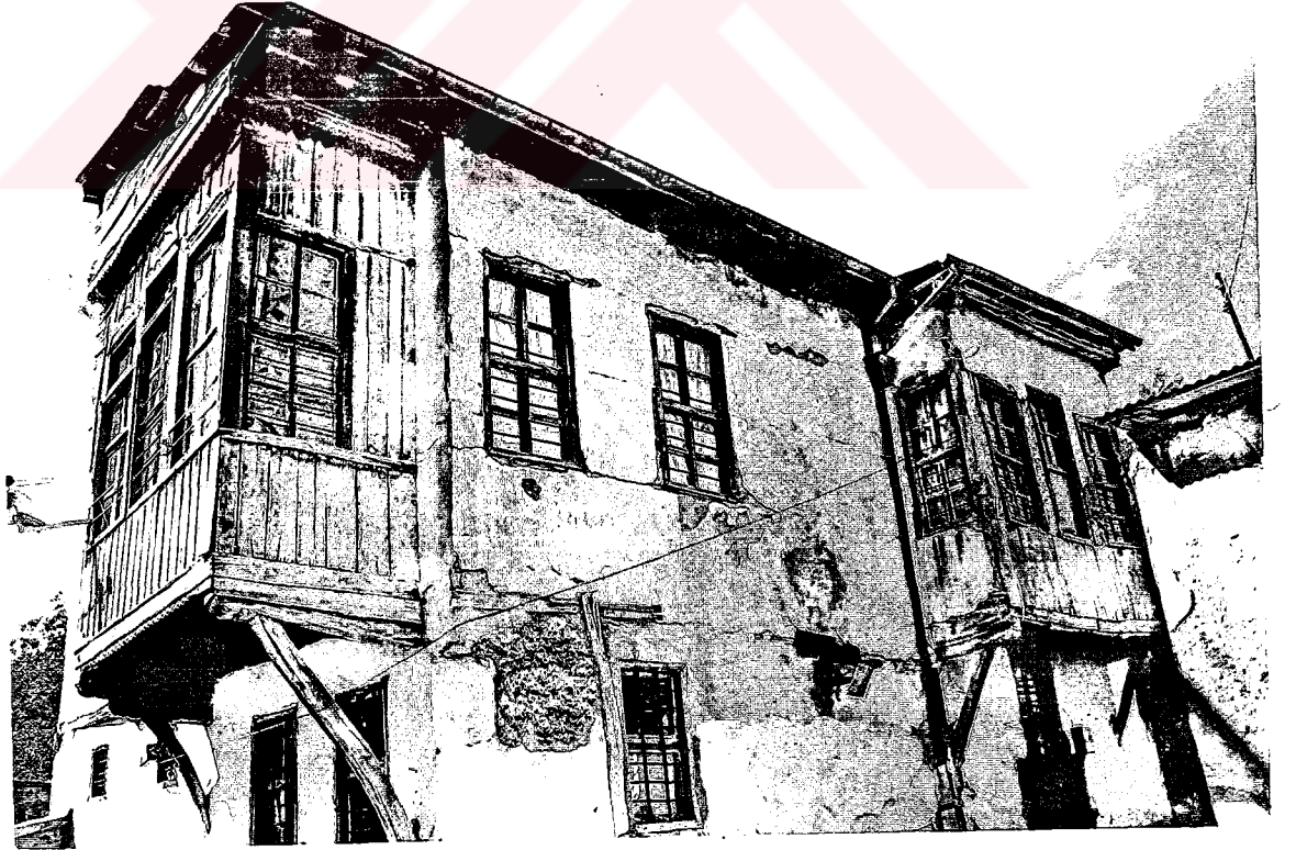
73- Necmettin Polat evinin çıkmalari ile güneydoğudan görünüşü
