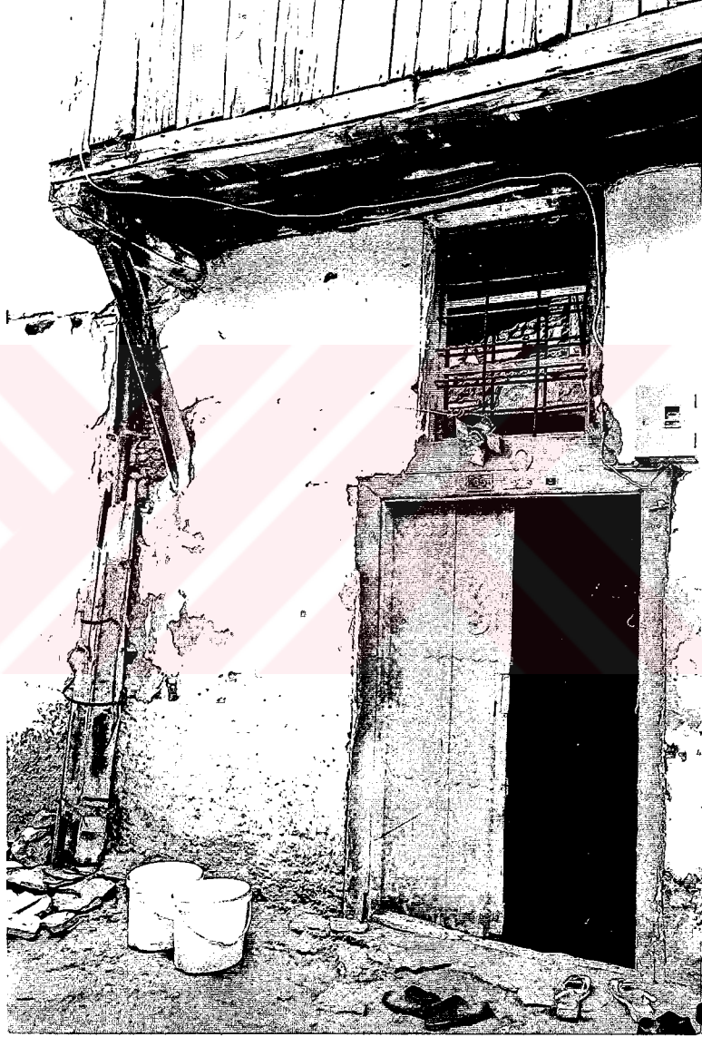
74- Necmettin Polat Evi kapı tokmaklı, kabaralı, çift kanatlı ahşap cümle kapısı
