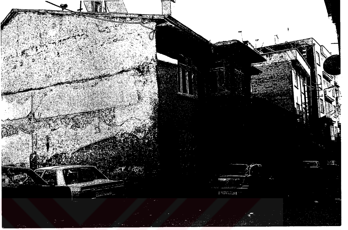
92- Mustafa Demirel Evi batı cephe kuzey uçtan görünüşü
