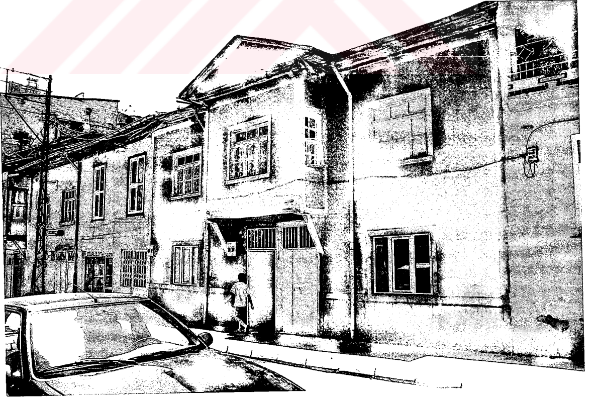
89- Celal Okşas Evi cephe kuzey uçtan görünüş
