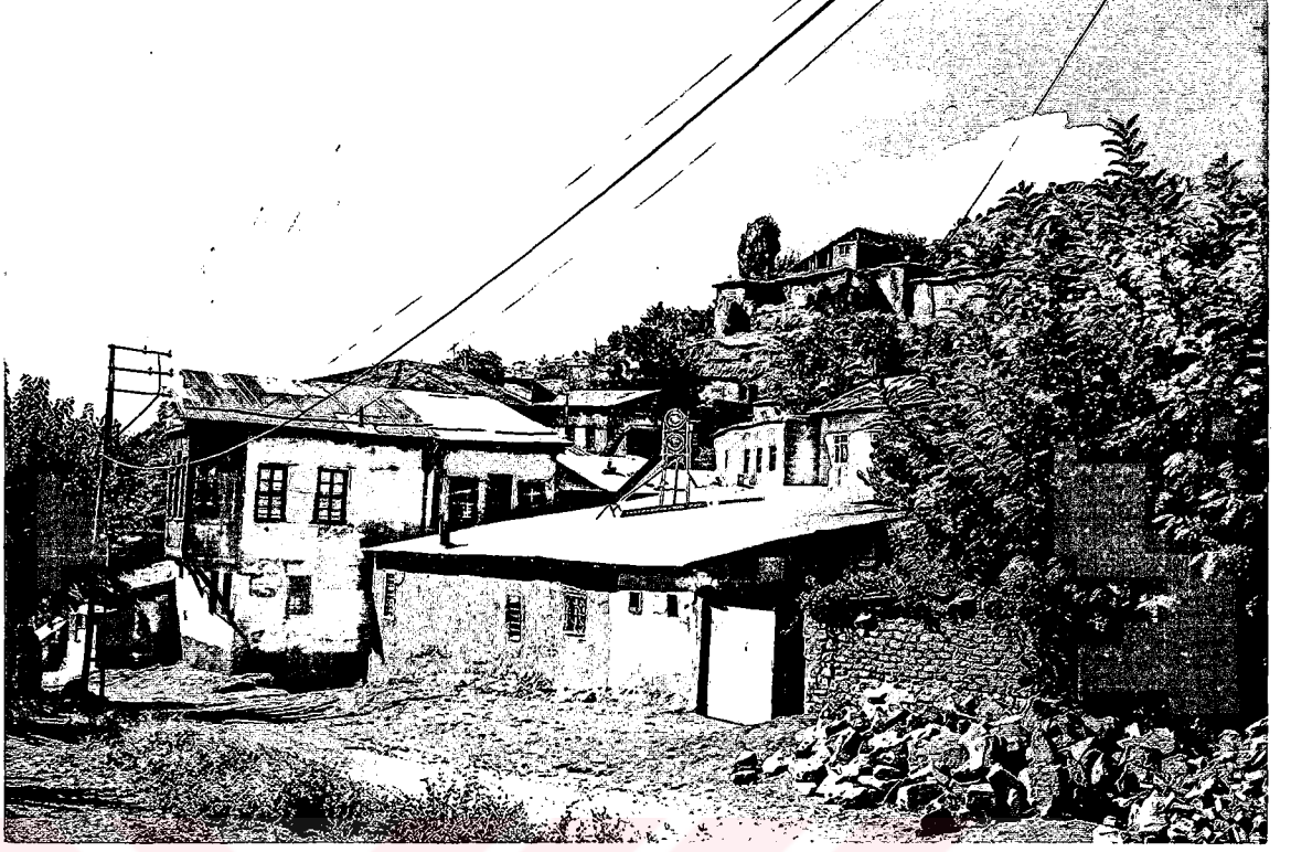
72- Necmettin Polat Evi güney cephe batı uçtan görünüşü
