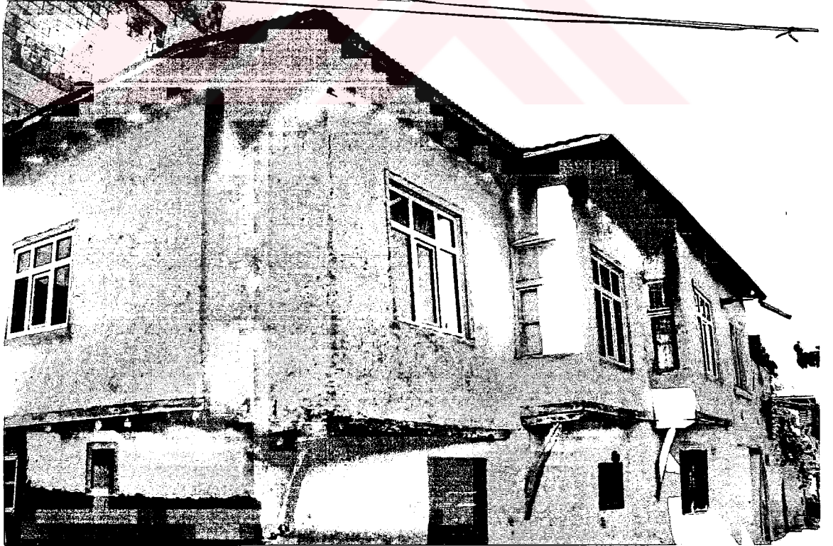
42- Celal Aksan Evi güney cephe batı uçtan görünüşü
