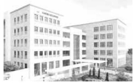
Büyükşehir Belediyesi, Kandıra için yeni ve modern bir hizmet binası yapacak.
