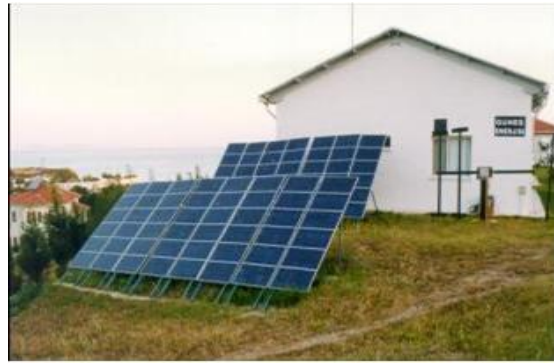
Şekil 4.4 Şebekeden bağımsız güneş sistemi
