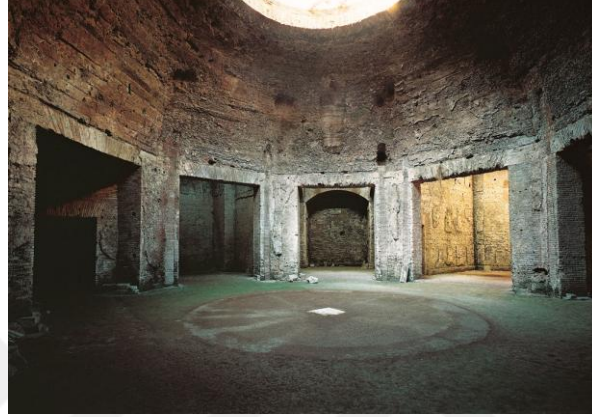
Resim 5 Domus Aurea İç Görünüşü (URL-2)
