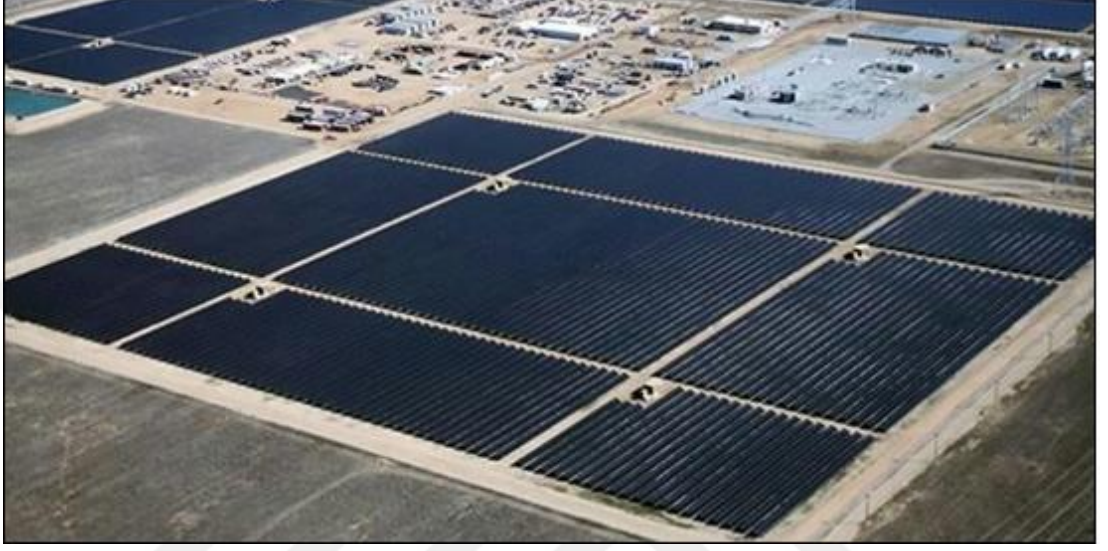
Şekil 1.8 Topaz Güneş Enerji Santrali [16].
