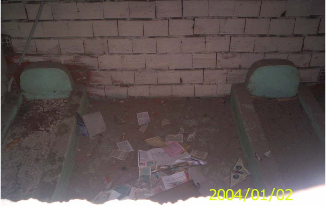
EK-26 Şeyh Üvendire Türbesi
