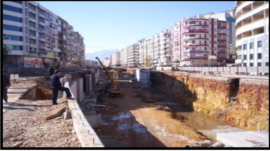
Foto 19: Alt Yapı Çalışmalarından Kaynaklanan Görüntü Kirliliği (Ulusoy Bulvarı).
