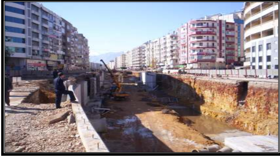
Foto 15: Alt Yapı Çalışmaları
