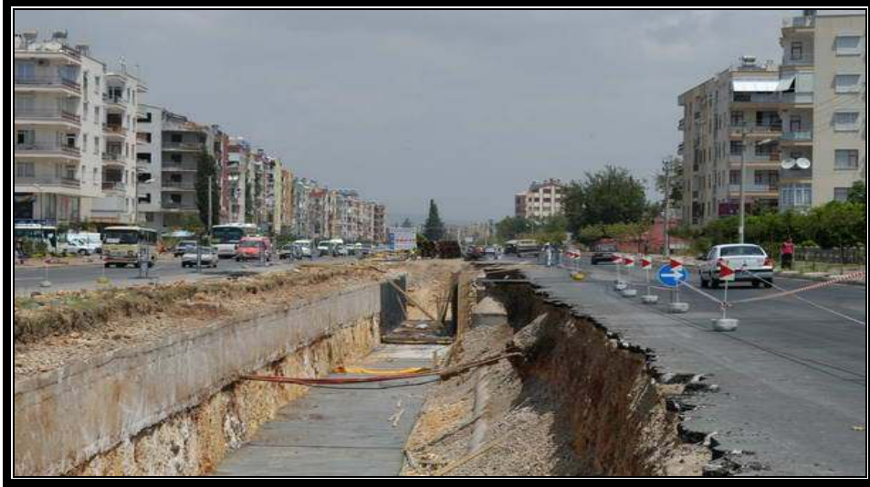
Foto 6: Alt Yapı Çalışmaları. Alt yapının artan nüfusun ihtiyaçlarına cevap verebilmesi amacıyla sürekli olarak yapılan çalışmalar görüntü kirliliğinin önemli nedenlerinden biridir.
