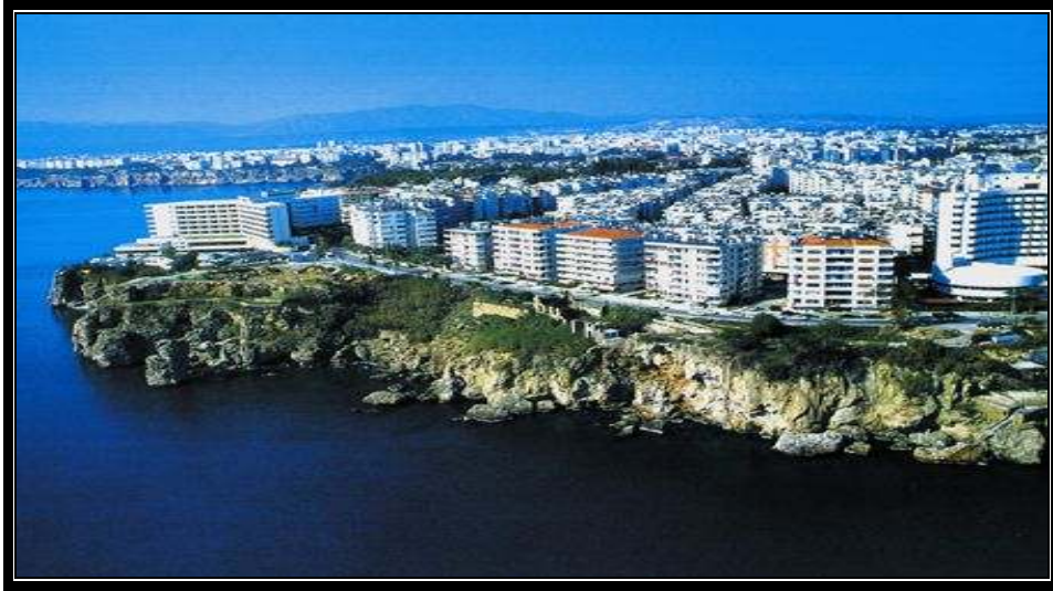
Foto 3: Kıyı Kesiminde Yer Alan Çok Katlı Yapılar(2006). Planlama sürecinde yapılan hatalar sonucu kıyıda yer alan çok katlı yapılar şehrin genel hava dolaşımı üzerinde olumsuz sonuçların doğmasına neden olmaktadır.
