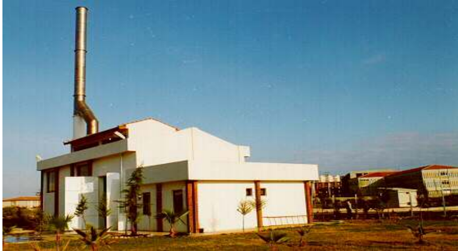
Foto 11: Tıbbi Atık Yakma Tesis
