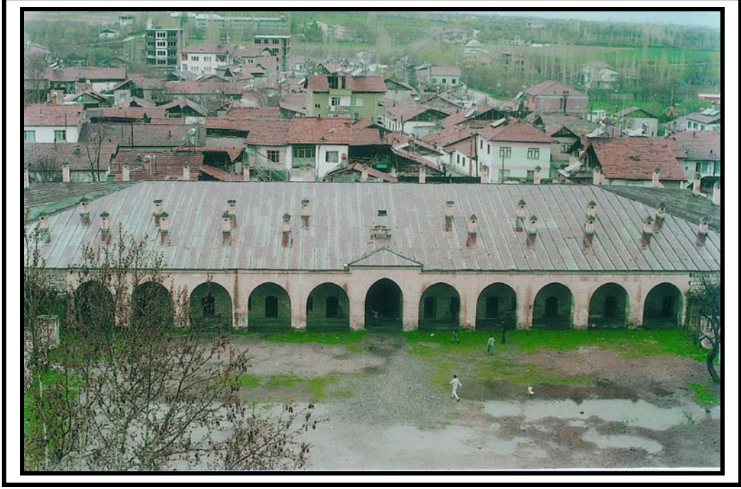
Foto: 4.11 Battalgazi ilçe merkezinde bulunan Silahdar Mustafa Paşa Kervansarayı'ndan bir görünüm (a:Battalgazi Bld.).
