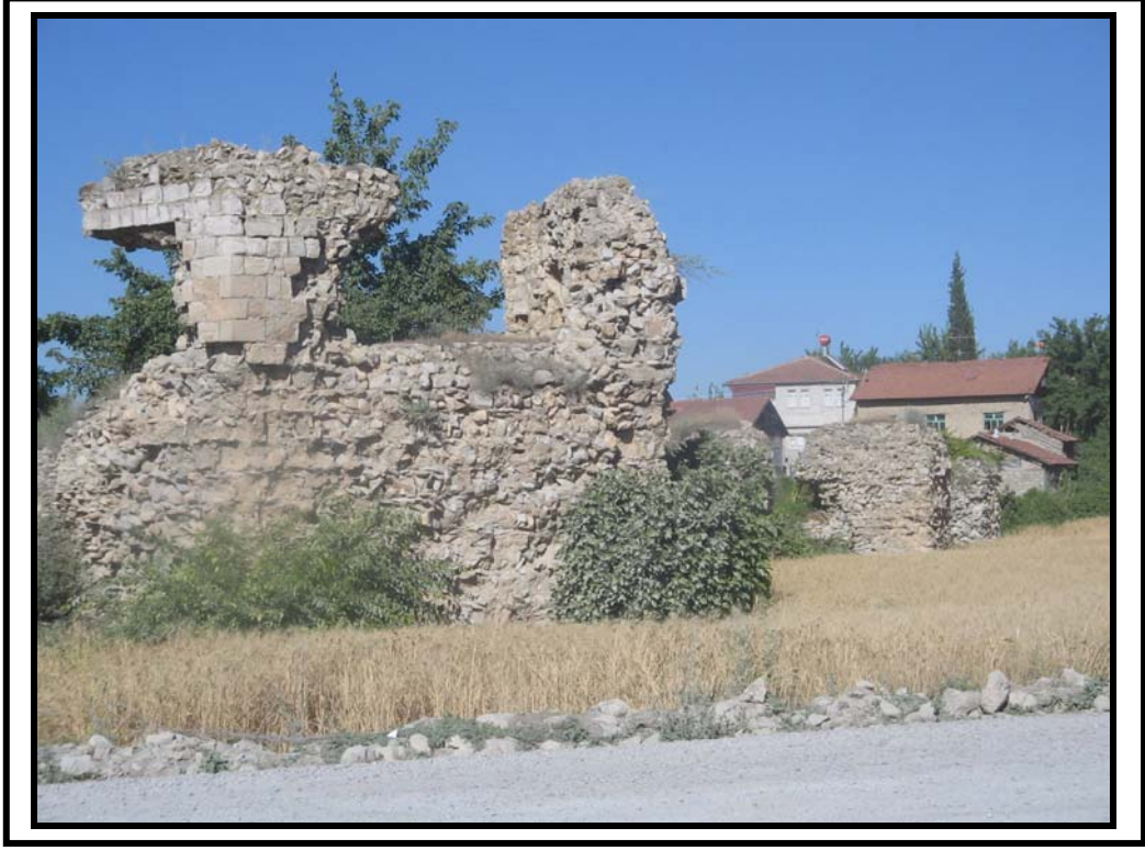
Foto: 4.10. Eskimalatya (Battalgazi) kalesi surlarından bir görünüm. Tarih boyunca çeşitli defalar onarım görmüş olan surların, bugün büyük bir bölümü ortadan kalkmış, hala ayakta kalabilen kısımları ise büyük ölçüde tahrip olmuş durumdadır (2005).
