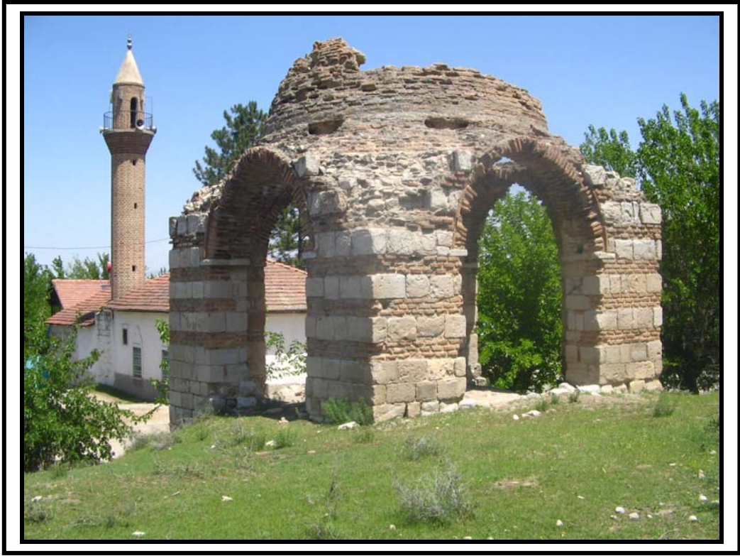
Foto: 4.16. Battalgazi ilçe merkezinde, Meydanbaşı Mahallesi'nde bulunan Kanlı Kümbet'ten bir görünüm. Kümbetin yıkılan kısımları Vakıflar Genel Müdürlüğü tarafından 2005 yılı içerisinde yeniden restore edilmiştir (2005).
