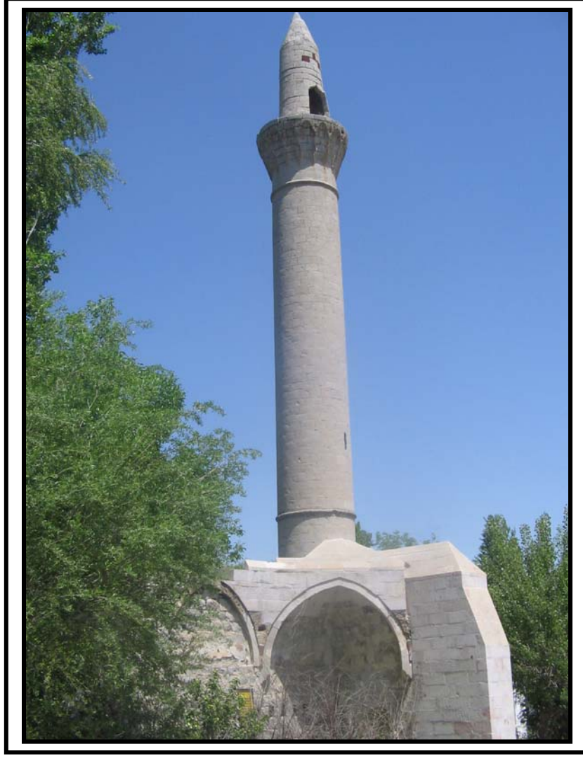
Foto: 4.17. Battalgazi ilçe merkezinde, Meydanbaşı Mahallesi'nde bulunan Sütlü Minare'den bir görünüm. Cami kısmı tamamen yıkılmış olan minarenin kaidesi son yıllarda onarılarak yıkılmaktan kurtarılmıştır (2005).
