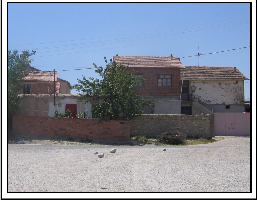
Foto: 3.9. Yarımcahan köyünde, yığma tekniği ile kerpiç ve tuğla malzemeden yapılmış meskenlerden bir görünüm. Son dönemlerde yapılmakta olan meskenlerde tuğla malzemenin daha yaygın olarak kullanıldığı görülmektedir (2005).
