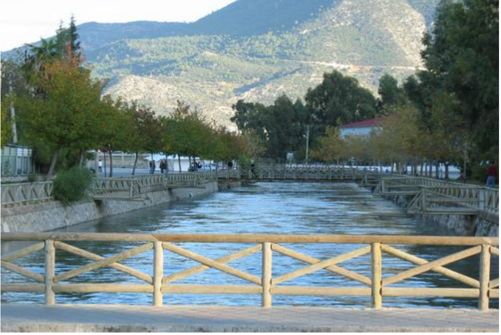
Şekil 3.3 DSİ Su Kanalı istasyonu görüntüsü
