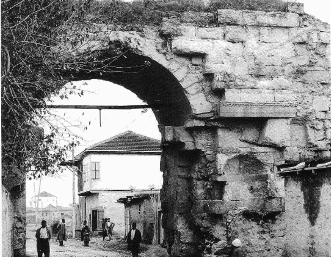
Res 7- Brian Johnson, Tarsus Amerikan Kolej'inin Gelişim ve Dönüşüm Evreleri ( Kleopatra Kapısı'nın ya da Kilikya Kapısı'nın 1920'li yıllardaki görüntüsü üzerine)
