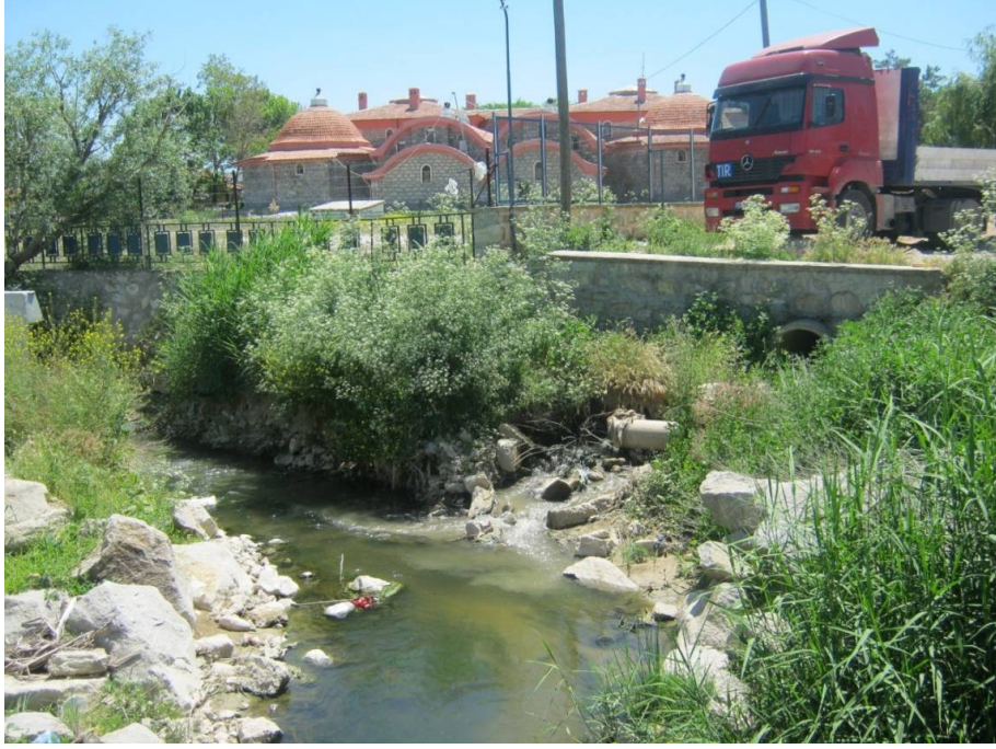
Şekil 4.6. Gazlıgöl Jeotermal Sahasında Termal Atık Suların Deşarj Noktası
