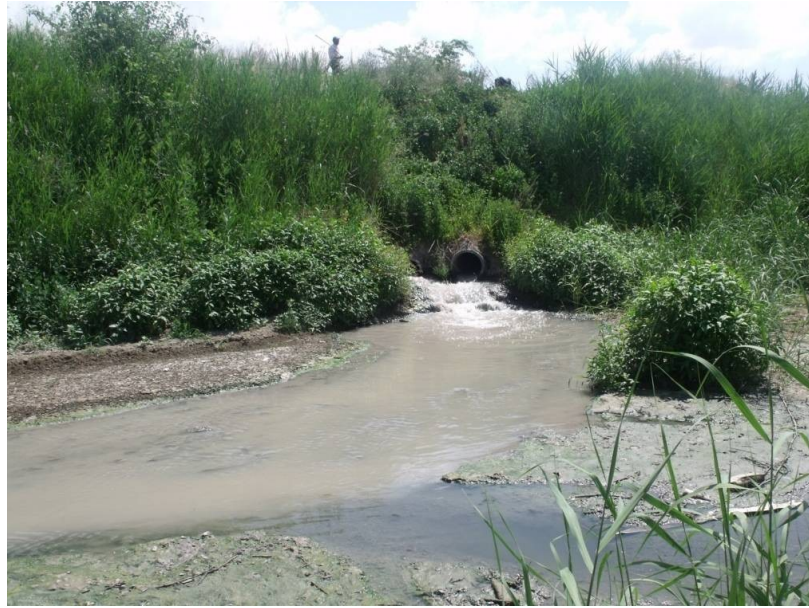
Şekil 4.1. Sandıklı Jeotermal Sahası Atık Suyu Deşarj Noktası
