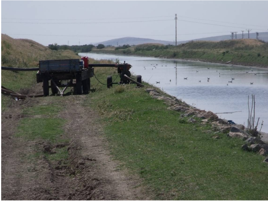
Şekil 4.5. Emaye ve Et Entegre Tesislerinin Atıklarının Karıştığı Develi Çayı'ndan Tarla Sulama İçin Su Çekilen Düzenek
