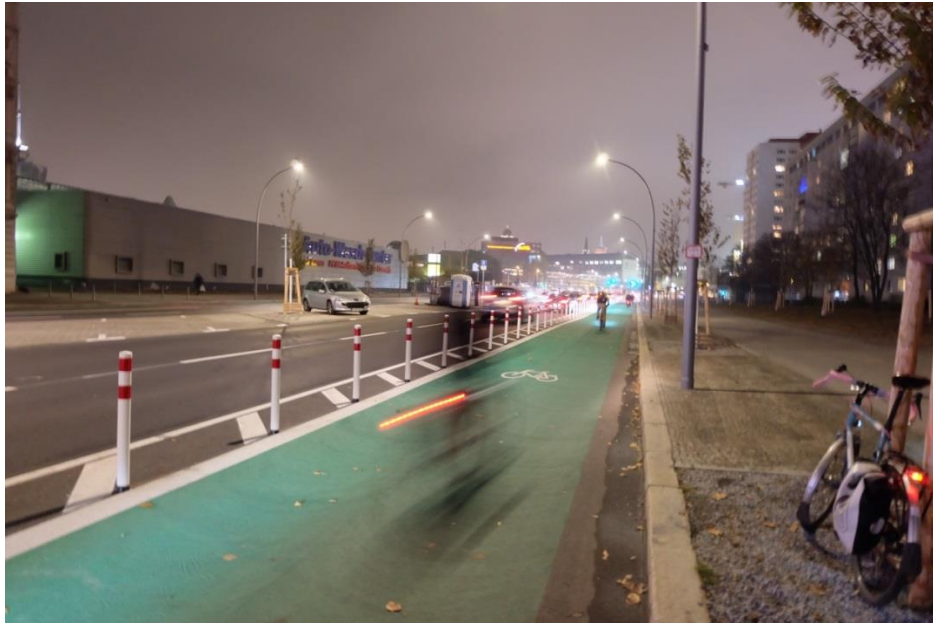
Görsel 4.24. Berlin'in Karayolundan Ayrılmış 2 m Genişliğindeki İlk Bisiklet Yolu (URL-75 Erişim Tarihi: 18.10.2019)
