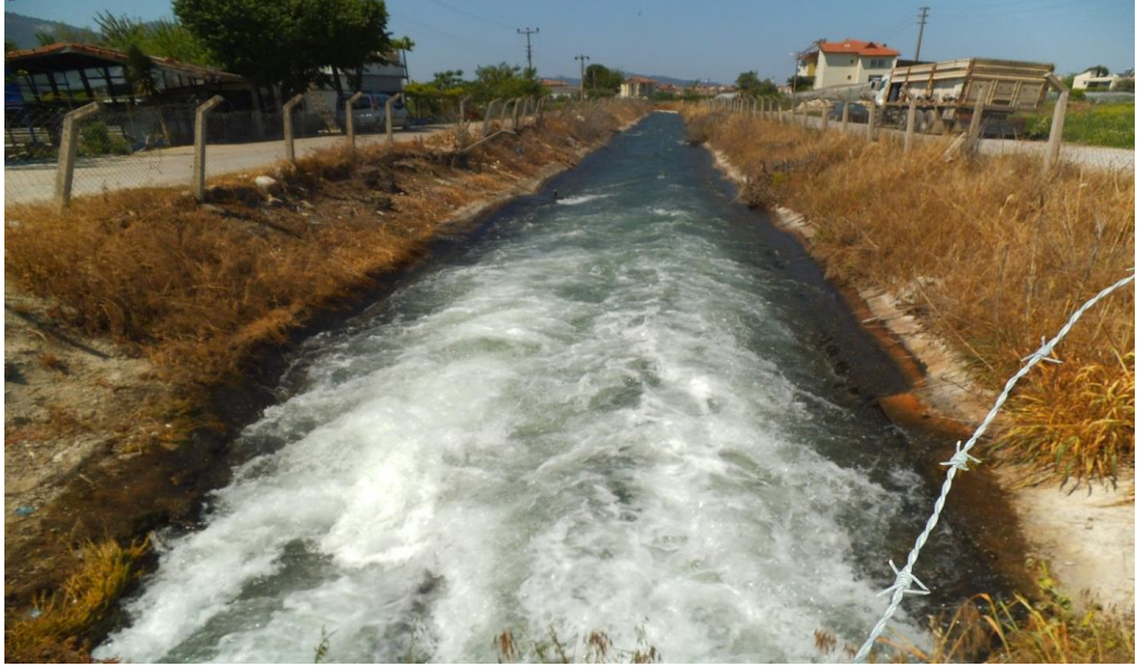
Şekil 3.2. DSİ drenaj kanalından bir görüntü
