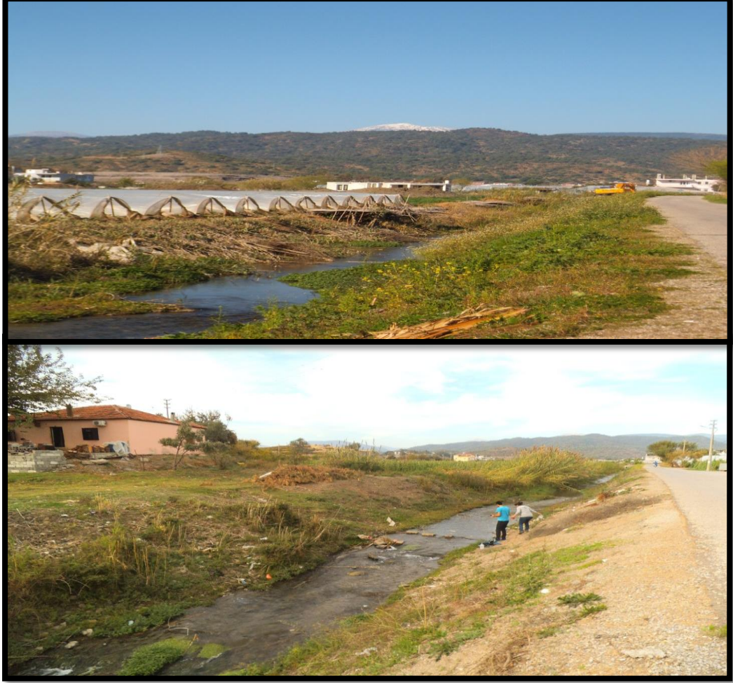
Şekil 3.6. İstasyonun farklı açılardan görünüşü
