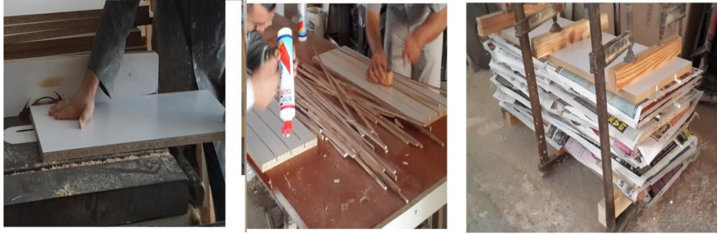
a. Kanalların açılması b. Çıtaların hazırlanması c. Çıtaların yapıştırılması
