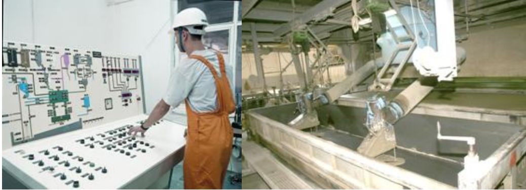
Şekil 5.3. Ytong Gazbeton Üretim Otomasyon Sistemi ve Gazbetonun Formelere Dökülmesi
