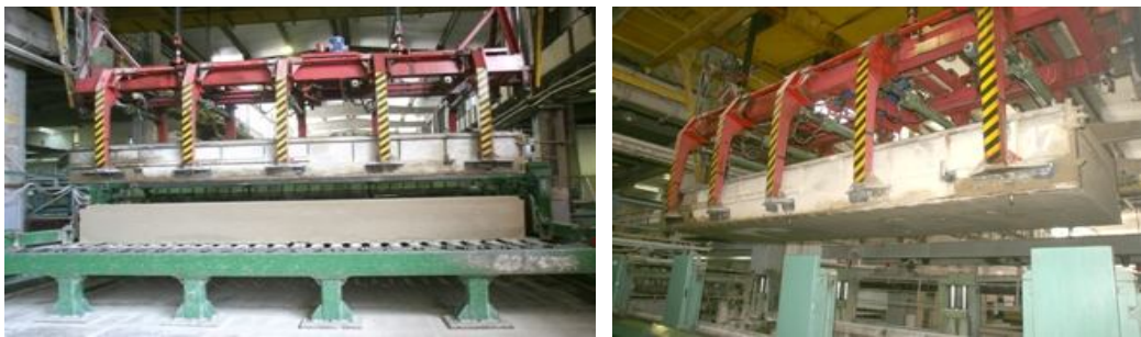
Şekil 5.4. Gazbetonun Bekleme ve Kuruma İstasyonu Tüneline Konulması ve Kesim Tezgahlarına Alınması
