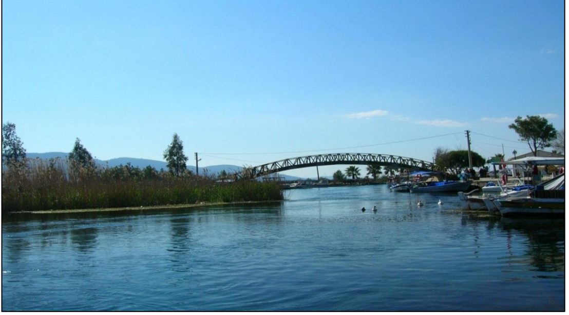
Şekil 2.13. Gökova limanı'nda yer alan köprü yakınında seçilen istasyon (orjinal)
