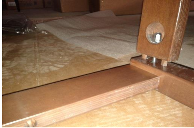
Őekil 3. 22.  n ayak-yan kayıt montajı
