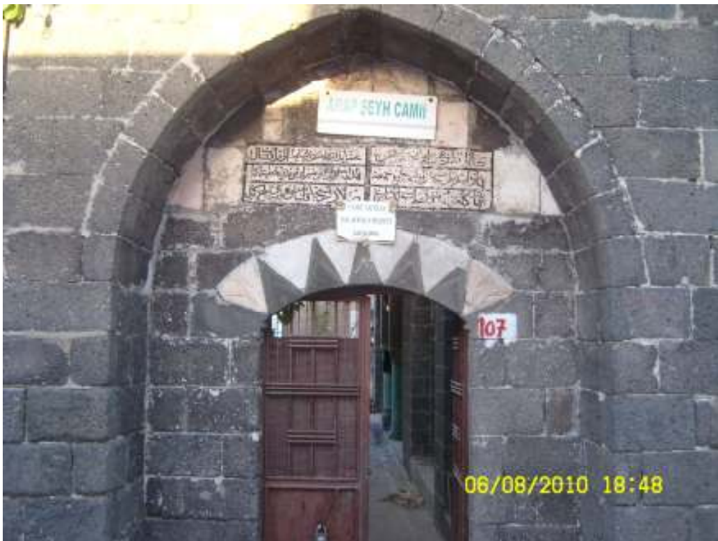
Resim 20: Arap Şeyh Türbesinin Bulunduğu Arap Şeyh Camii-Diyarbakır Merkez
