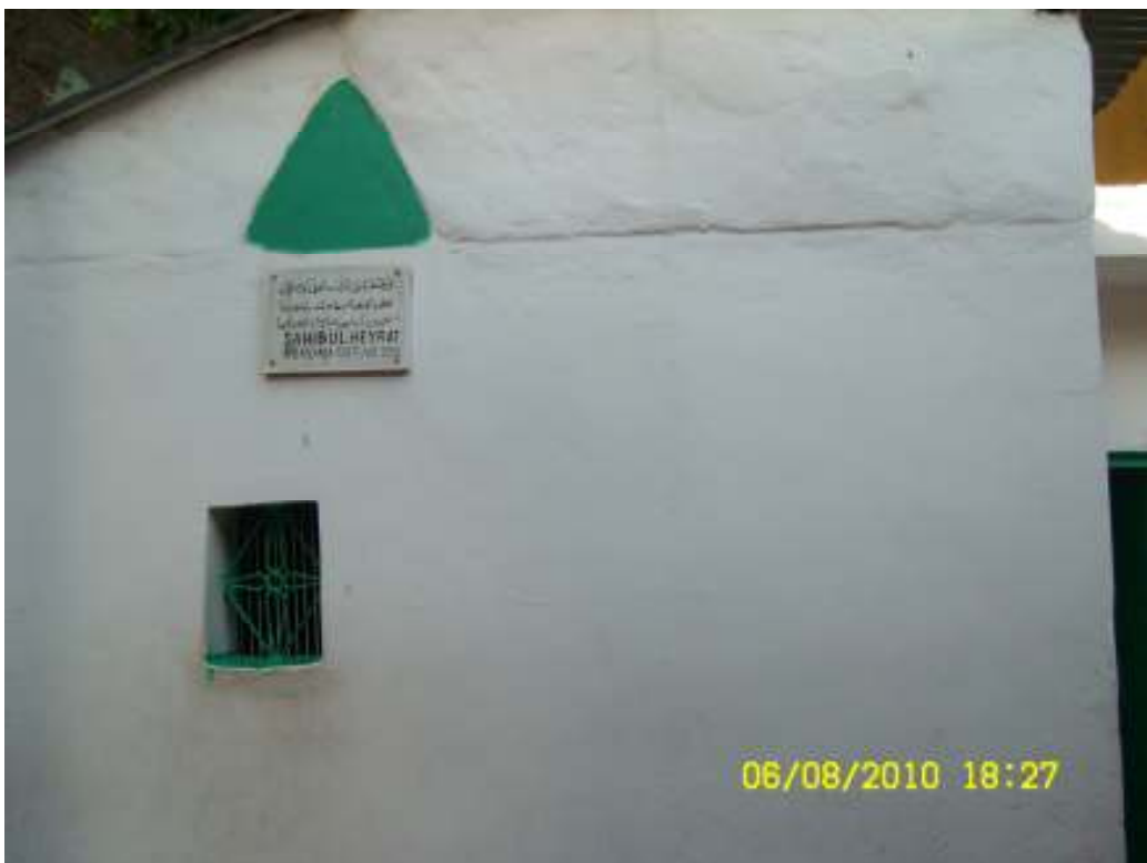
Resim 18: Beyaz (Akmezar) Türbe-Diyarbakır Merkez
