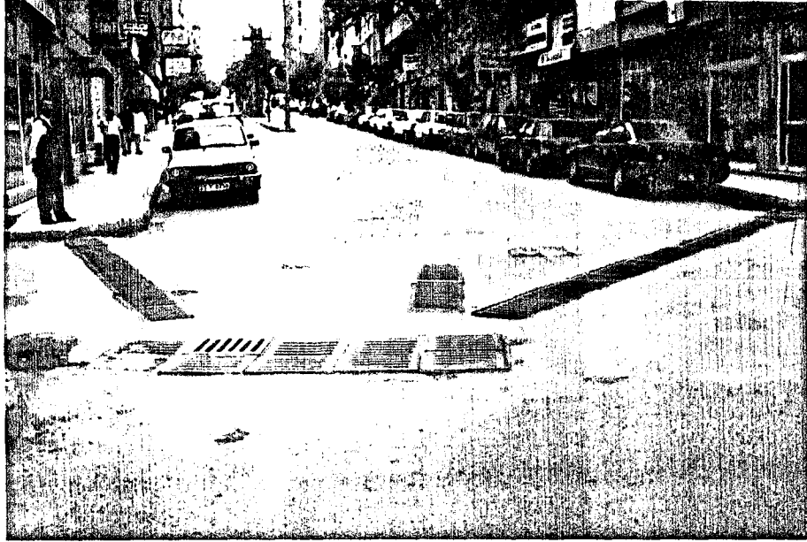
Resim 5.9. İki yolun birleşme yerinde yapılan drenaj çalışması
