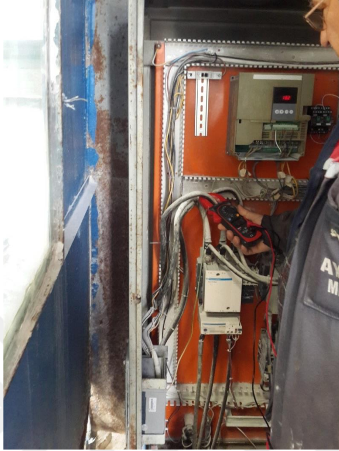
Resim 5.16. Pens ampermetre ile mermer fabrikasında yapılan ölçümler
