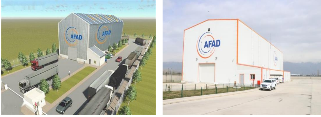
Şekil 2. 2. Lojistik Depo Yapım Aşamaları
