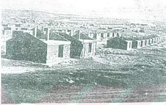
Şekil 4.5. Kars afet konutları inşaatı (Afet İşleri,1977)
