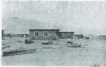
Şekil 4.1. Erzincan'da Avusturya firmasınınca yapılan konutlar(Koyunoğlu, 1977)
