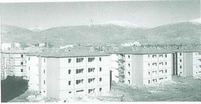
Şekil 4.12 Erzincan'da tünel kalıp sistemiyle yapılan afet konutları
