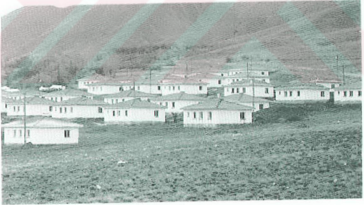
Şekil 4.13. Erzincan'da yapılan köy tipi kalıcı konutlar
