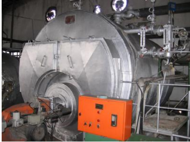
Şekil 3.2: Deri fabrikada kullanılan skoç tipi buhar kazanı
