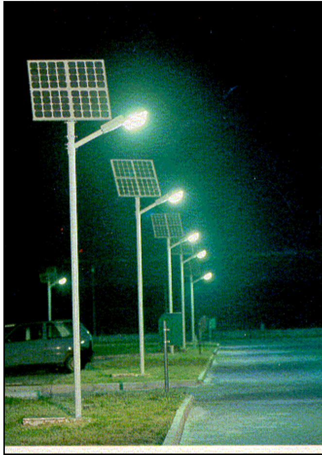
Şekil 2.13: Güneş Pilleri ile Sokak Aydınlatması
