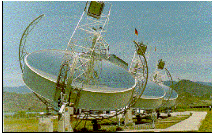
Şekil 2.5: Parabolik Çanak Güneş Isıl Elektrik Santrali (İspanya)
