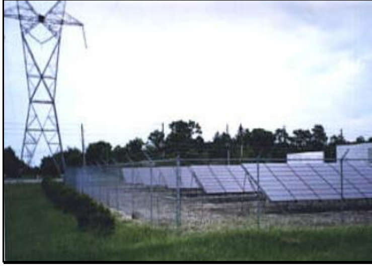
Şekil 2.16: Şebekeye Elektrik Veren Güneş Pili (PV) Sistemi
