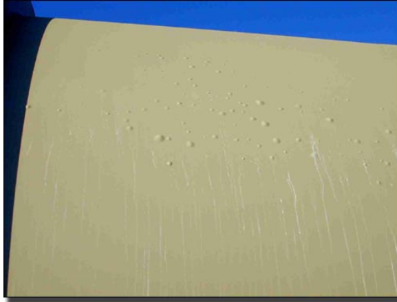
Şekil 4.6: Boyada "Blistering (Kabarma)" oluşumu.
