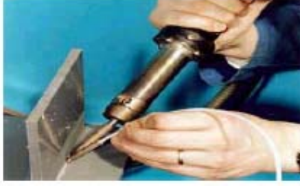
Şekil 2.3: Sıcak gaz kaynağının uygulaması (www.petzetakis-africa.co.za)
