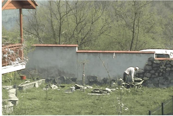
Şekil 6.9: Kayrak taşı kaplama işinde taşın harçla kaplanması
