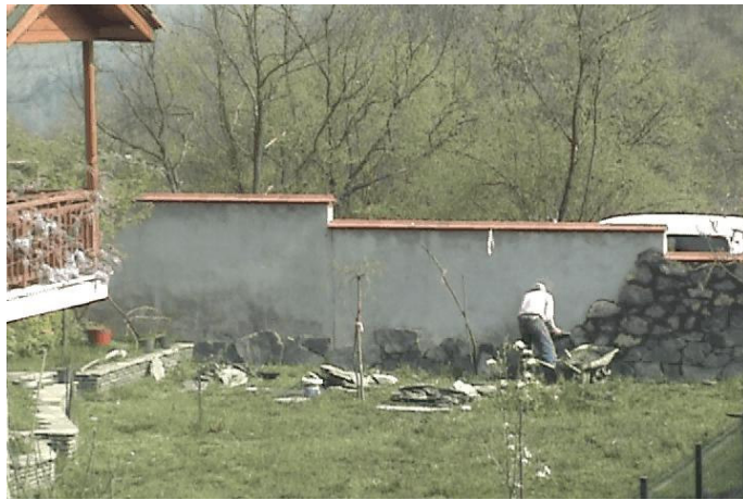
Şekil 6.10: Kayrak taşı kaplama işinde taşın duvara yapıştırılması
