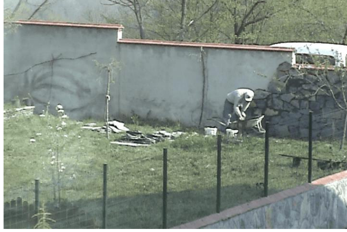
Şekil 6.8: Kayrak taşı kaplama işinde harç hazırlama
