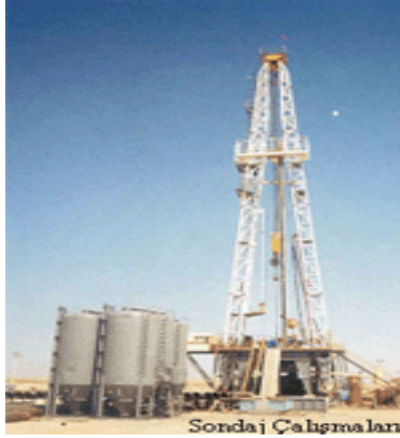
Şekil 6.2: Tuz Gölü Yeraltı Doğal Gaz Depolama Projesi Sondaj Çalışması. [32]
