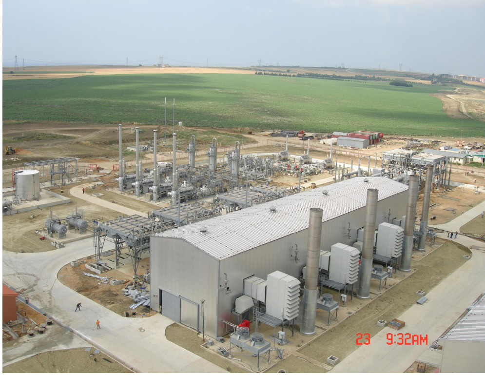
Şekil 8.6: Yüzey Tesislerinin Görünümü. [19]
