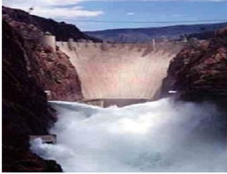
Şekil 4.6: Berke Barajı'nın görüntüsü
