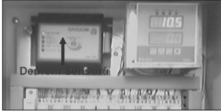
Şekil 5.4 Ana kumanda panosu içi deprem sensörü (www.ipragaz.com.tr,2007)
