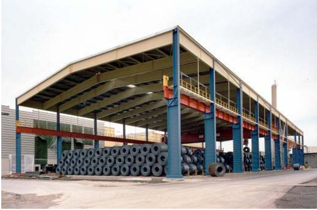
Şekil 4.4: Sin Profil Kullanılarak İnşa Edilen Antrepo
