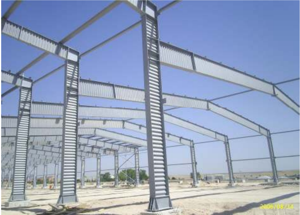
Şekil 4.5: Sin Profil Kullanılarak İnşa Edilen Fabrika Binası
