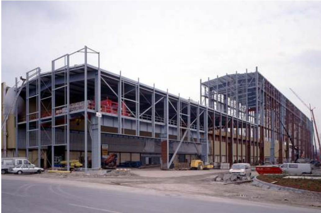
Şekil 4.3: Sin Profil Kullanılarak İnşa Edilen Endüstriyel Yapı
