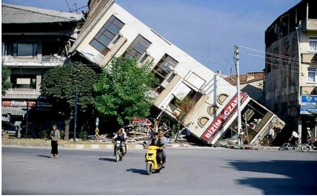
Şekil 4.2. 17 Ağustos 1999 depremi sonrasında zeminde meydana gelen taşıma gücü kaybı (JMO, Sıvılaşma Semineri).
