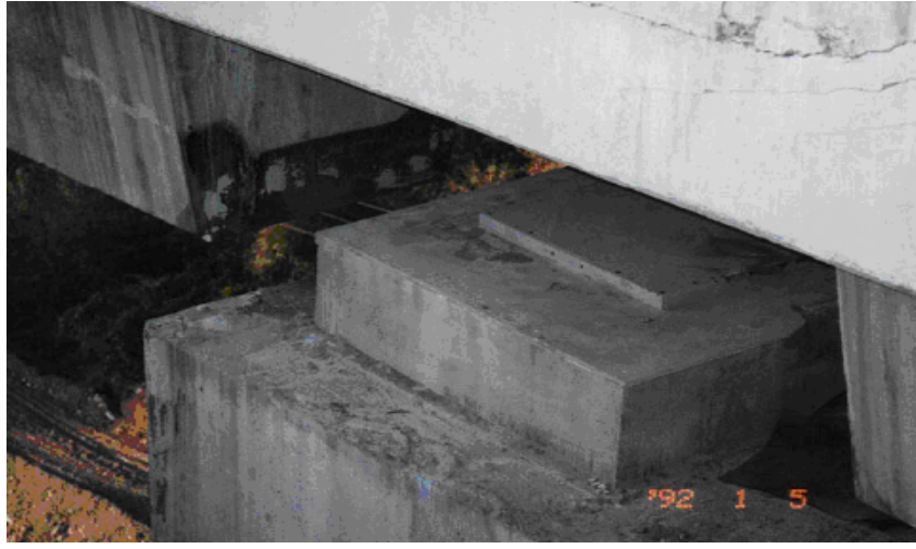
Şekil 1.19: Bolu viyadüğü mesnetlerinde meydana gelen ötelenmeler [28]
