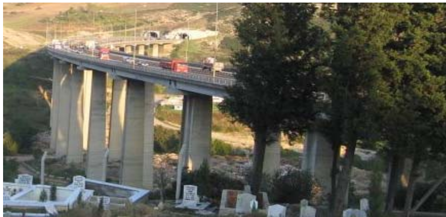
Şekil 2.2: Hatipdere viyadüğünün yandan görünüşü [31]
