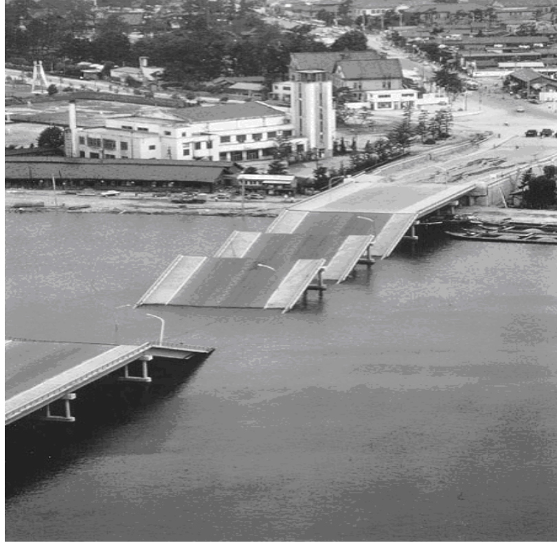
Şekil 1.16: 1964 Nigata depreminde Showa köprüsünde meydana gelen sıralı tabliye hasarı [28]
