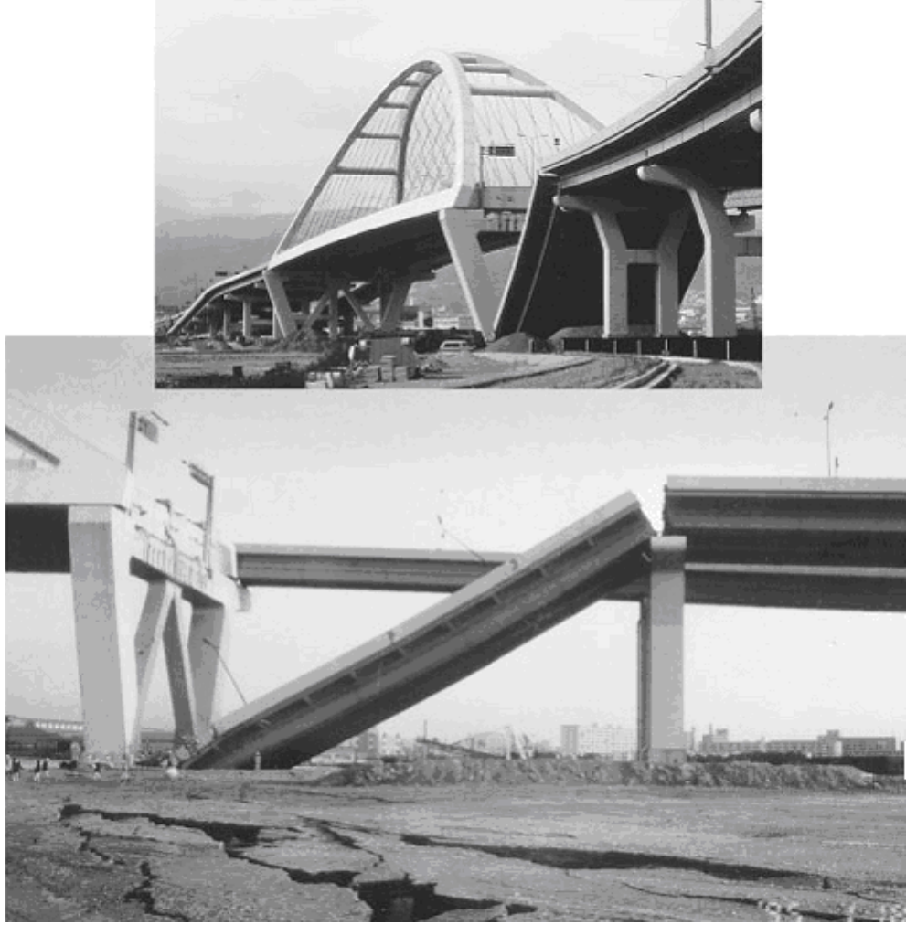
Şekil 1.14: 1995 Kobe depreminde Nishinomiya-ko köprüsü hasarı [19]
