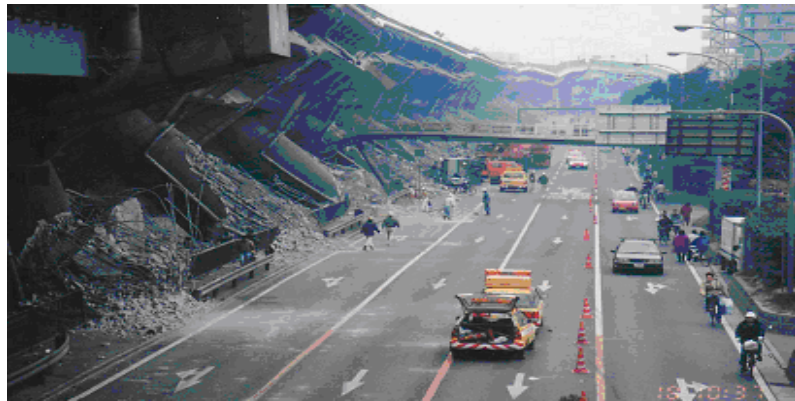
Şekil 1.7: 1995 Kobe depremi sonucu Fuake viyadüğünün genel durumu [28]
