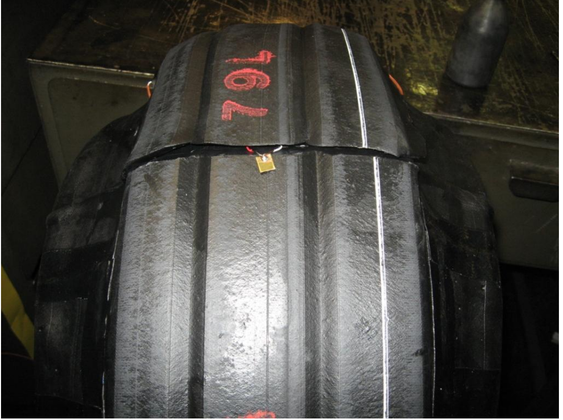
Şekil 6.25: 5.kontrol noktasına ısıçift yerleştirilmesi
