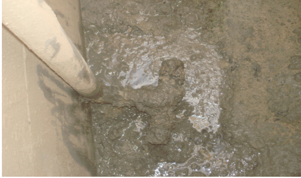
Şekil 6.18: Yağ tutucuda organik madde çökmesi
