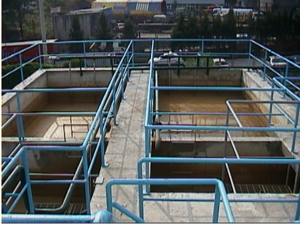
Şekil 2.10: Biyolojik arıtma biriminin şematik görünümümü
