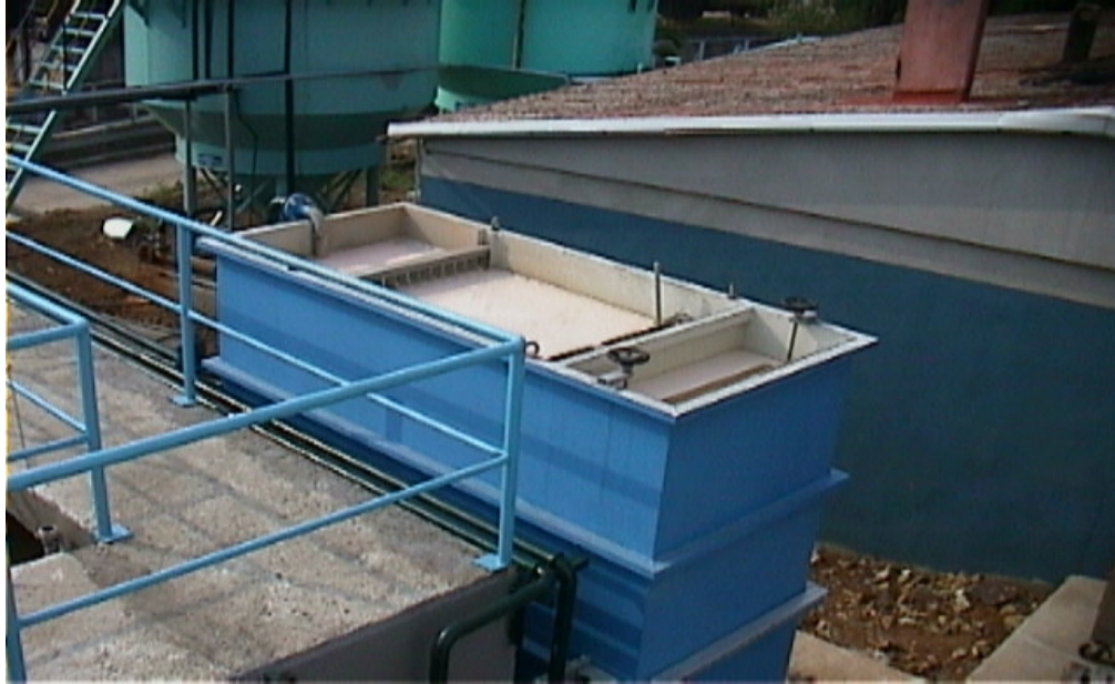
Şekil 2.8: Fiziksel arıtma biriminin şematik görünümü
