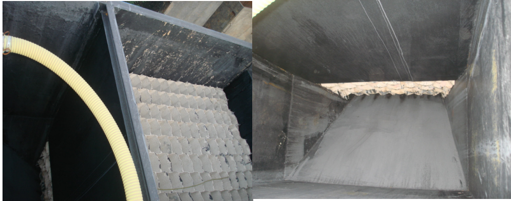
Şekil 6.19: Konik tabanlı yağ tutucu görünümü-1
