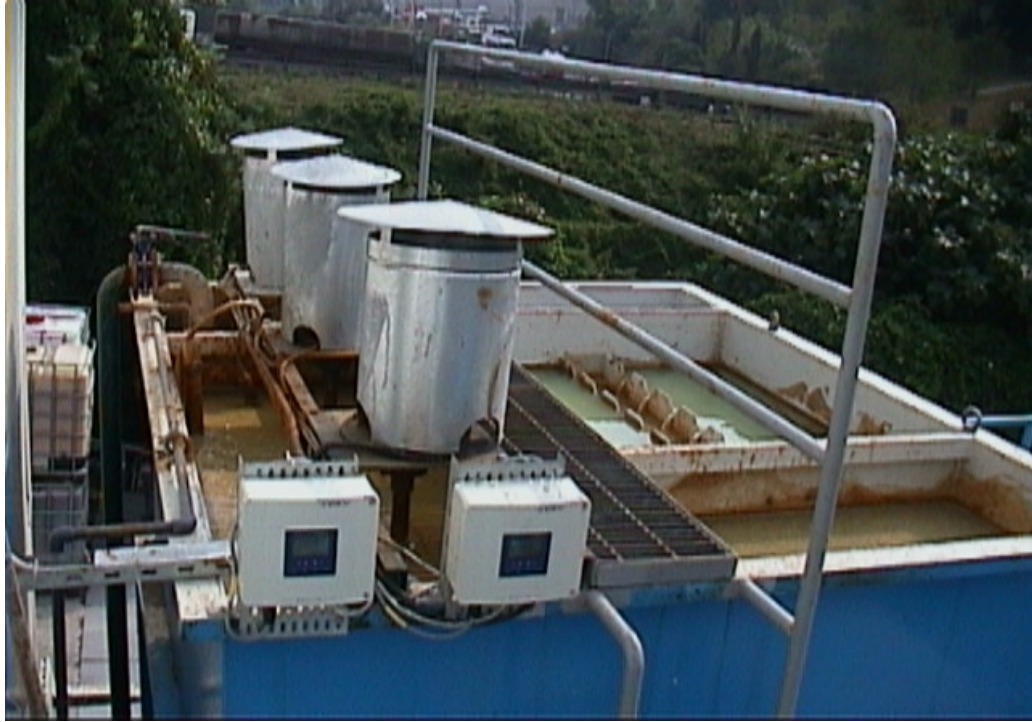
Şekil 2.9: Kimyasal arıtma biriminin şematik görünümü
