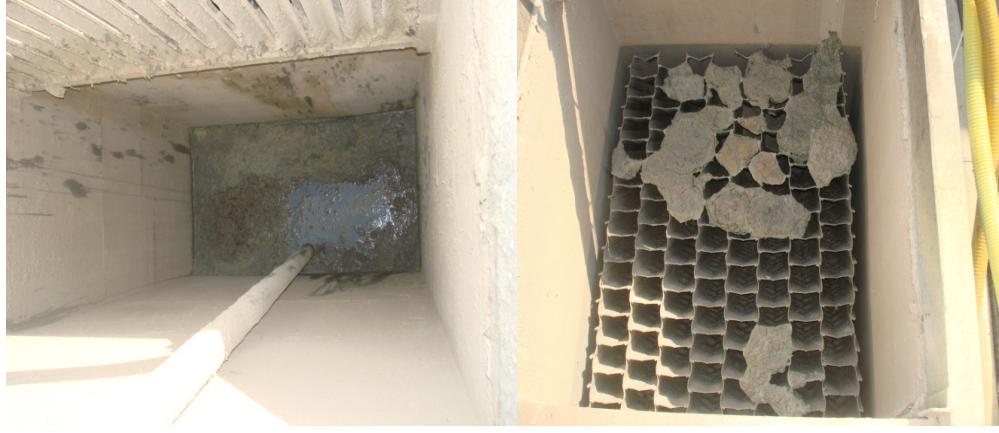
Şekil 6.17: Dikdörtgen tabanlı yağ tutucu görünümü
