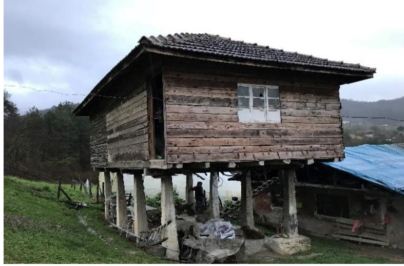
Resim 4.6. Dört direk üzerine oturtulmuş ambar niteliği gören kulübemsi yapı Serander (Kahraman, 2018)
