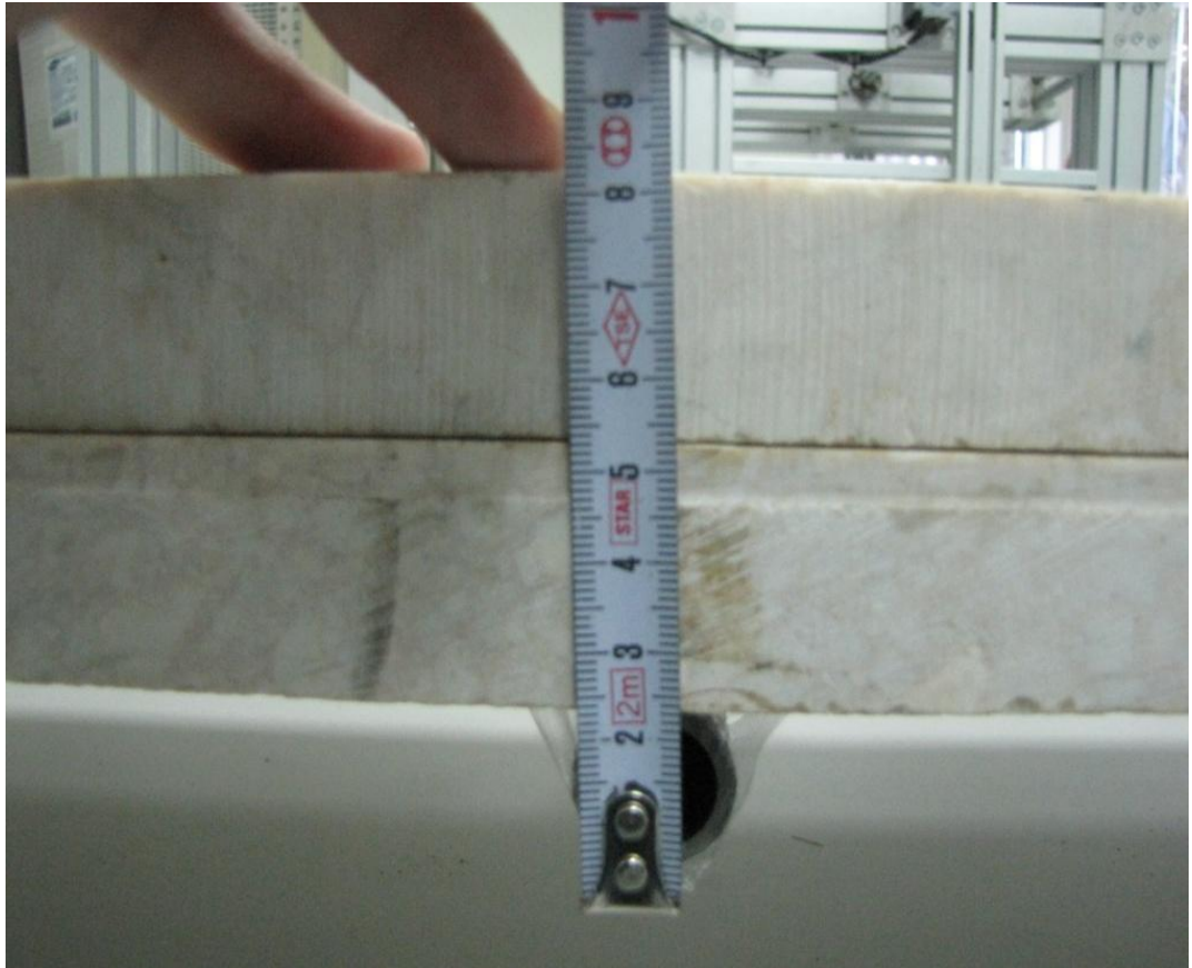
Şekil 2.9: Mermer altına yerleştirilmiş metal boru
