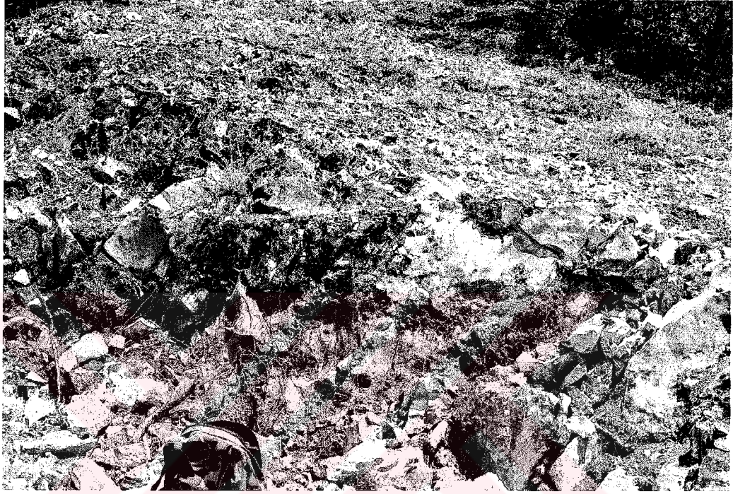
Şekil 2.14. Karabakır Formasyonu'nun kireçtaşları. Mustafa Mahallesi 2 km. GD'sunda. Bakış GD'ya doğru.
