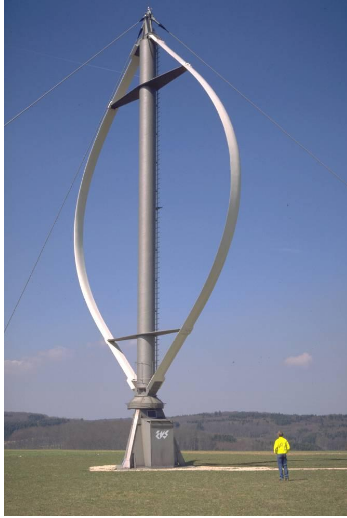
Şekil 3.4: Düşey eksenli Darrieus tipi bir rüzgar türbini [23]
