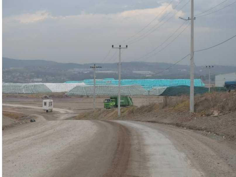
Şekil 4.3: Gebze kentsel katı atık balyalama tesisinin genel görünümü
