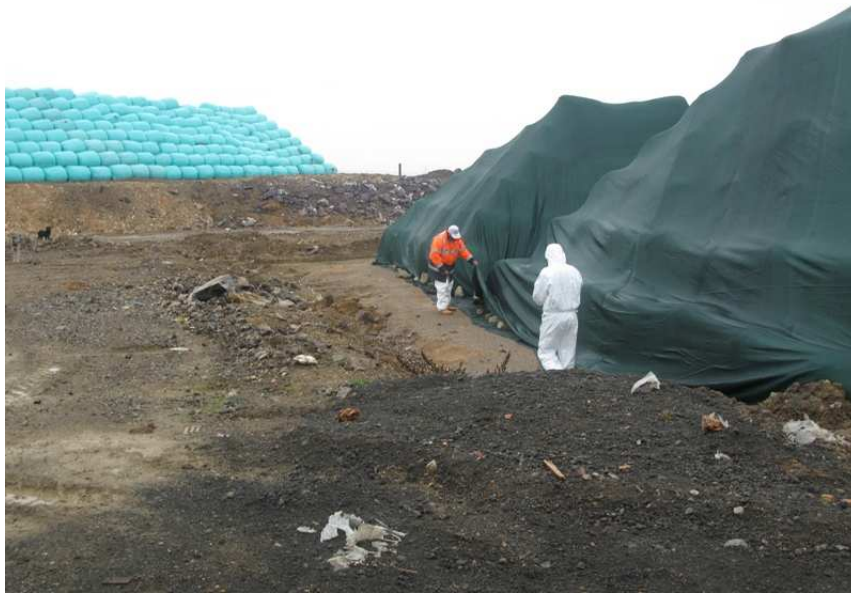
Şekil 3.5: Hazırlanan balyaların polietilen malzeme ile örtülmesi
