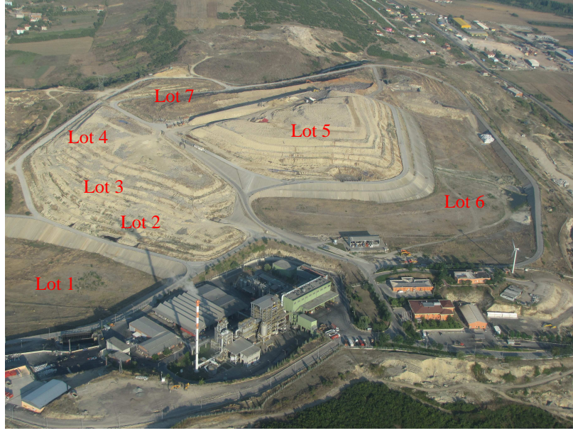
Şekil 4.2: Solaklar düzenli depolama tesisinin genel görünümü
