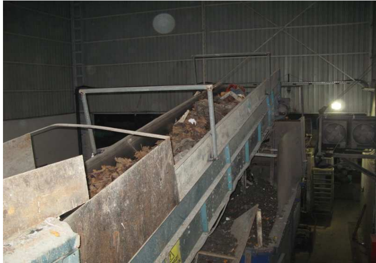
Şekil 4.11: Elenmiş ve ayrıştırılmış kentsel katı atıkların öğütücüye aktarılması
