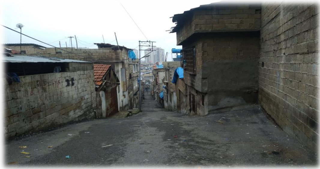
Fotoğraf 1: Nuri Pazarbaşı Mahallesi Gecekondu Yapılaşması
