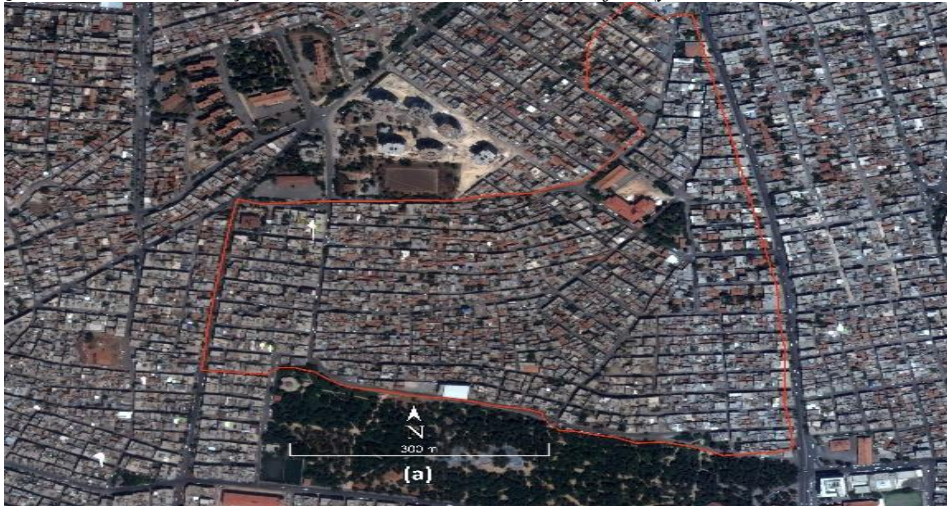
Şekil 5: Nuri Pazarbaşı Mahallesi Kentsel Dönüşüm Projesi (yıkım öncesi)
