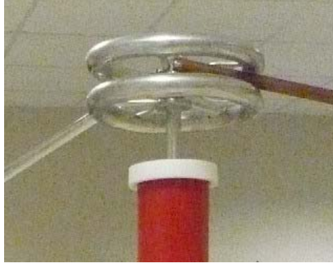
Şekil 6.4: Kuplaj kondansatörü bağlantı başlığı.
