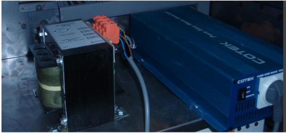
Şekil 4.70: Çalışmada kullanılan DA/AA dönüştürücü olan eviricinin görünümü
