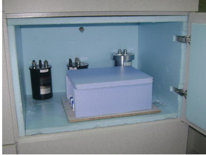
Şekil 7.6: Ahşap düzeneğin izolasyonlu dolap içersine yerleştirilmesi
