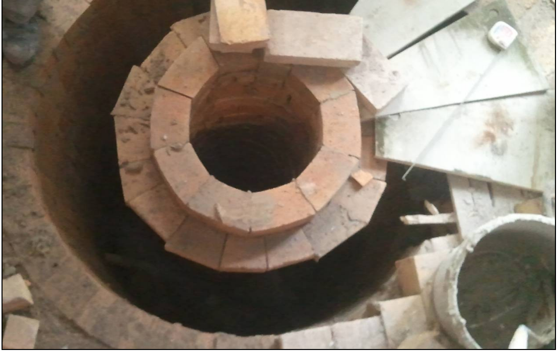
Şekil 3.10. Siklon tavan detayı
