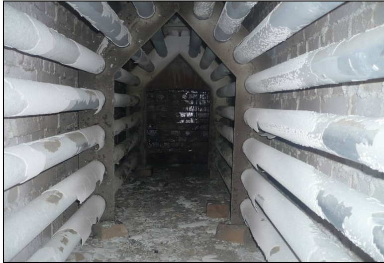
Şekil 3.24. Siklondan sonra bacada biriken toz görüntüsü
