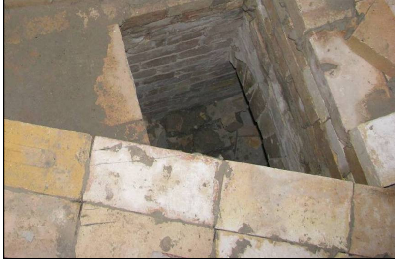
Şekil 3.4. Fırın baca çıkışı - siklon girişi arası tüneli resmi
