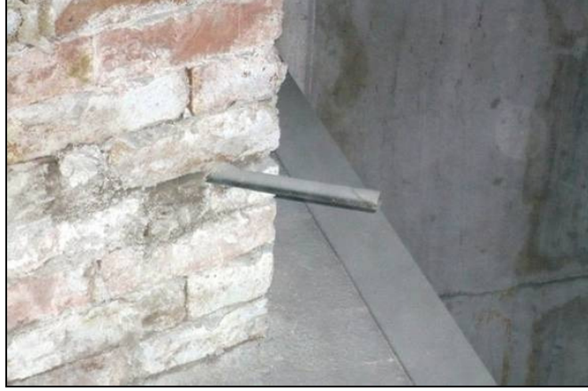
Şekil 3.20. Siklon çıkış basınç ölçüm noktası resmi
