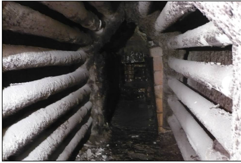
Şekil 3.23. Siklondan önce bacada biriken toz görüntüsü
