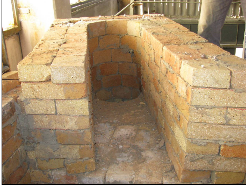
Şekil 3.11. Siklon – reküperatör bölgesi baca kanalı
