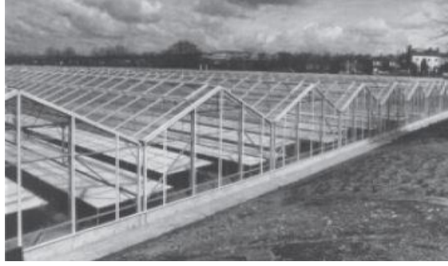
Şekil 1.3. Sera yapımında kullanılan alüminyum iskeletler [4]
