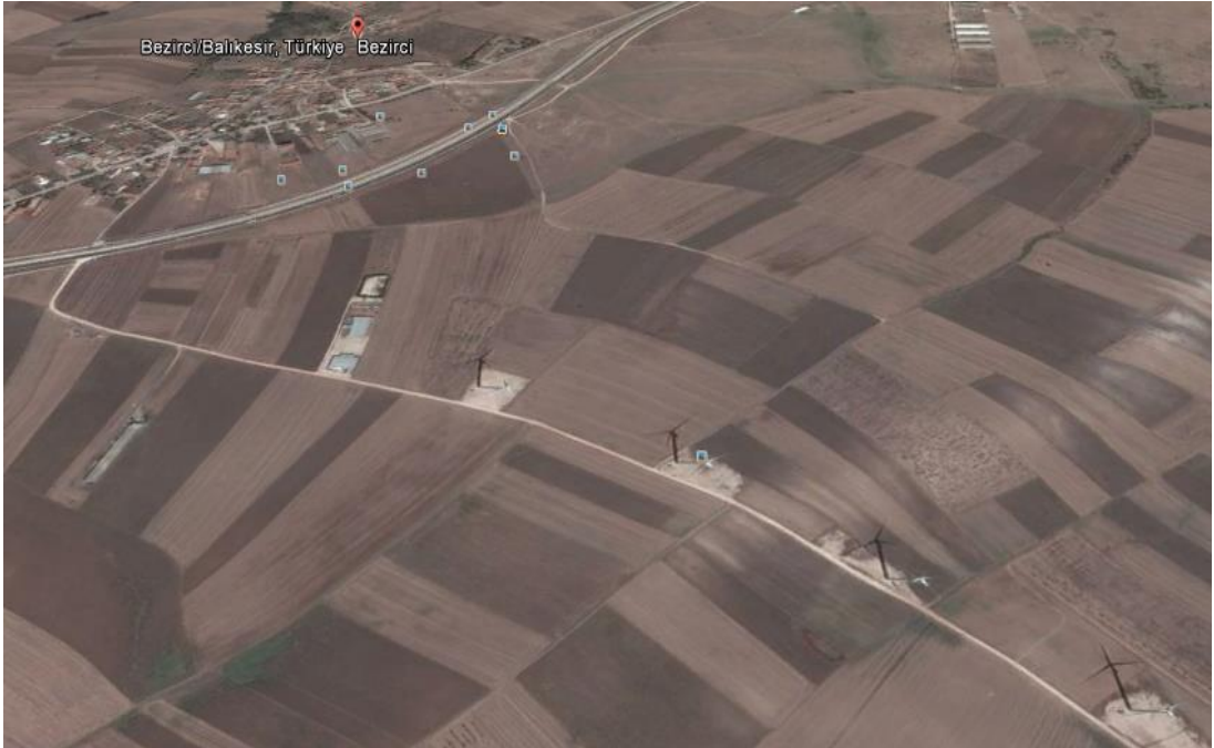
Şekil 1.6. Bandırma Bezirci Köyü 24 MW rüzgar enerji santrali uydu görüntüsü
