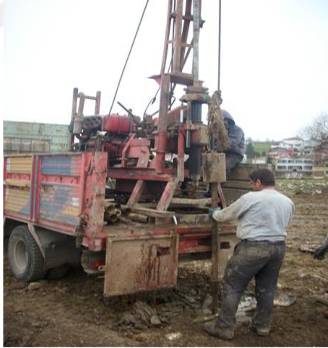
Şekil 1.8. Şahmerdanın düşürülmesi
