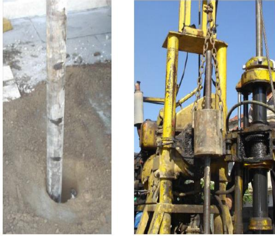
Şekil 1.7. Tijin işaretlenmesi ve şahmerdanın yerleştirilmesi
