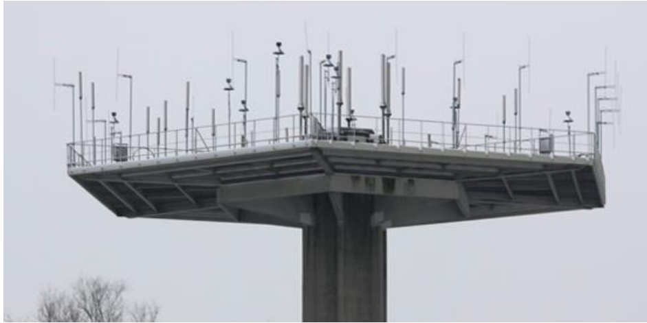
Şekil 2.2. ACARS sisteminden gelen bilgileri toplayan anten
